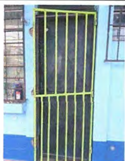
Foto 3: MODULO 1 - SUSTITUCION DE PUERTA DE REJA
