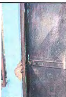
Foto 5: MODULO 1 - MANTENIMIENTO A ESTRUCTURA DE PUERTA
