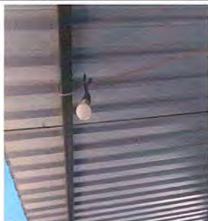
Foto 15: MODULO 2 - SUSTITUCION DE LAMPAS LED
