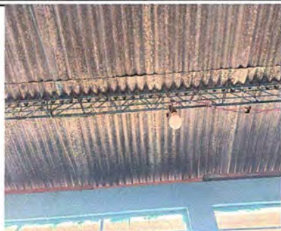
Foto 7: MODULO 1 - SUSTITUCION DE LAMPARAS LED
