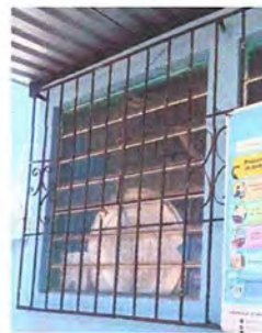
Foto 14: MODULO 2 - MANTENIMIENTO A BALCONES DE METAL
