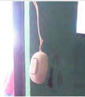
Foto 16: MODULO 2 - SUSTITUCION DE INTERRUPTORES
