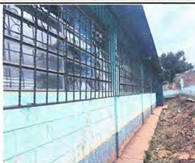
Foto 20: PINTURA EN MUROS EXTERIORES E INTERIORES
