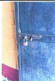
Foto 4: MODULO 1 - SUSTITUCION DE CHAPA
