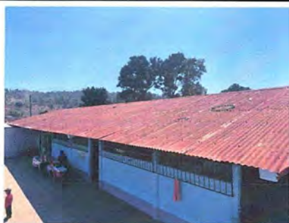
Foto 1: MODULO 1 - SUSTITUCION DE LAMINA POR LAMINA TROQUELADA
