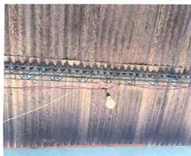
Foto 8: MODULO 1 - INSTALACION DE UNIDADES DE LUZ
