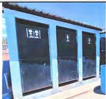
Foto 19: MODULO 4 MANTENIMIENTO A ESTRUCTURA DE PUERTAS
