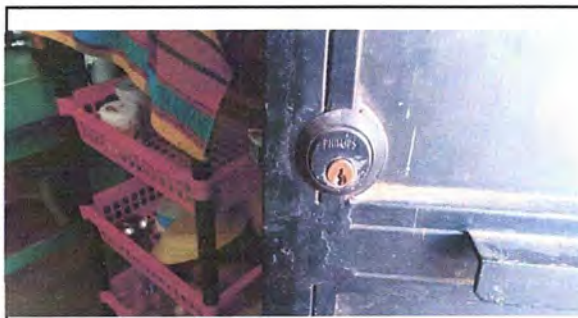
Foto 12: MODULO 2 - SUSTITUCION DE CHAPA
