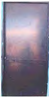
Foto 13: MODULO 2 - MANTENIMIENTO A ESTRUCTURA DE PUERTA
