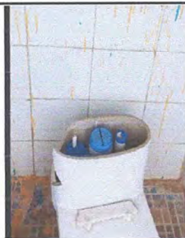
FOTO 9 MODULO 4. SUSTITUCION DE ACCESORIOS INODORO (CONTRA LLAVE, TUBO DE ABASTO Y TANQUE).
