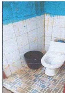
FOTO 8. MODULO 4. SUSTITUCION DE INODORO
