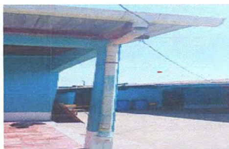
FOTO6. MODULO II: SUSTITUCION DE CANAL PVC
