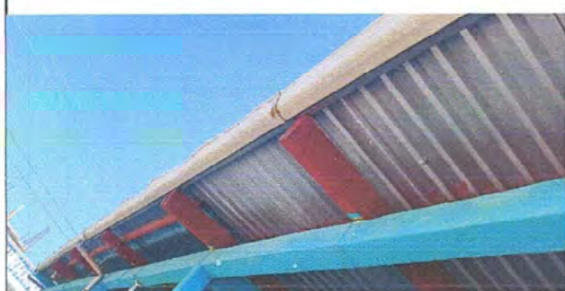
FOTO 3 MODULO 1. SUSTITUCION DE CANAL PVC
