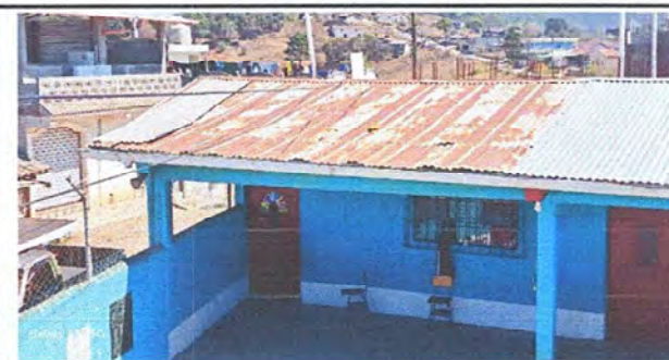
FOTO 4. MODULO II: SUSTITUCION DE LAMINA, POR LAMINA TROQUELADA ALUZINC CALIBRE 26
