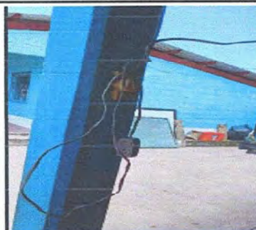
FOTO 12. MODULO 6: INSTALACION DE ACOMETIDA ELECTRICA
