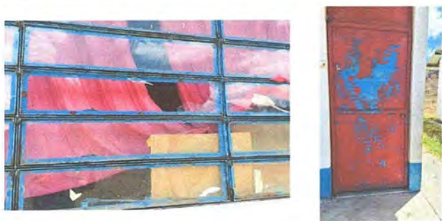
Foto 28 y 29: Módulo 2: Sustitución de vidrios y mantenimiento a estructura de puerta.
