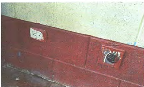
Foto 3: Módulo 1: Sustitucion de tomacorriente
