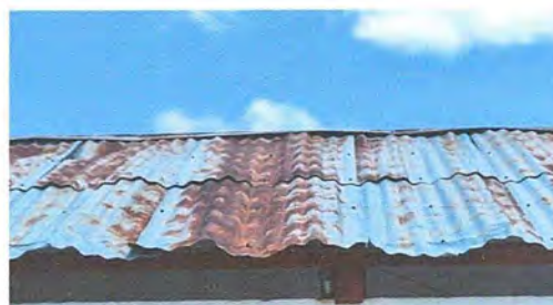
Foto 12: Módulo 2: Sustitución de capote de lámina para lámina troquelada
