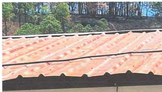
Foto 23: Módulo 3: Sustitucion de capote de lamina por lamina troquelada
