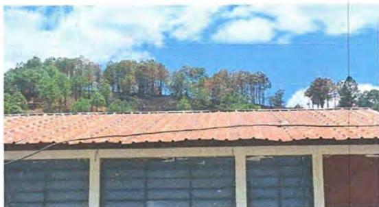
Foto 22: Módulo 3: Sustitución de lamina por lamina troquelada aluzinc calibre 26
