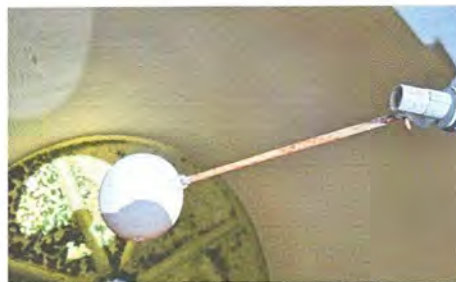
Foto 32: Módulo 4: Sustitución de accesorios depósito de agua
