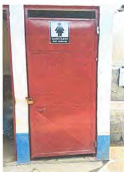
Foto 31: Módulo 4: Mantenimiento a estructura de puertas (alijado, cepillado y pintado)
