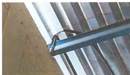
Foto 2: Módulo 1: Sustitucion ducto electrico mas accesorios
