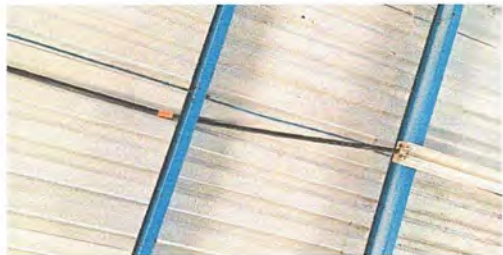
Foto 1: Módulo 1: Reparación cableado electrico
