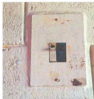
Foto 30: Módulo 2: Sustitución de flipones
