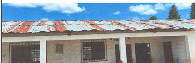
Foto 11: Módulo 2: Sustitución de lamina por lamina troquelada aluzinc calibre 26
