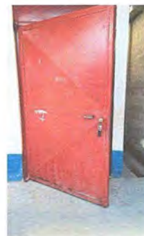
Foto 8: Módulo 1: Mantenimiento a estructura de puerta (lijado, cepillado, pintado)
