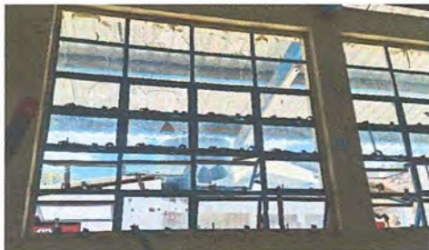
Foto 7: Módulo 1: Sustitución de vidrios
