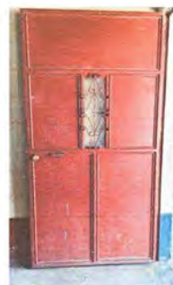
Foto 17: Módulo 2: Mantenimiento a estructura de puertas (alijado, cepillado y pintado)
