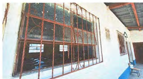
Foto 19: Módulo 2: Sustitución de vidrios
