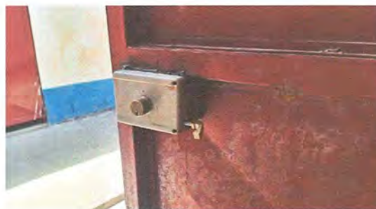
Foto 10: Módulo 1: Sustitución de chapa YALE
