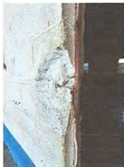
Foto20: Módulo 2: Sellado de grieta y fisura en muro
