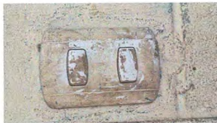
Foto 6: Módulo 1: Sustitución interruptores
