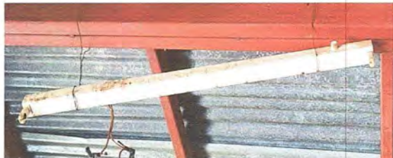
Foto 13: Módulo 2: Sustitución de focos ahorradores, plafoneras y cableado eléctrico
