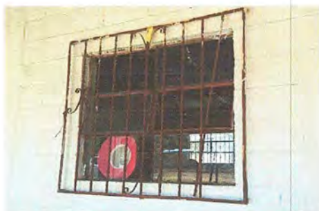
Foto 16: Módulo 2: Mantenimiento a balcones de metal
