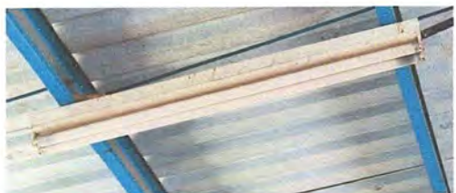
Foto 5: Módulo 1: Sustitución plafonerías
