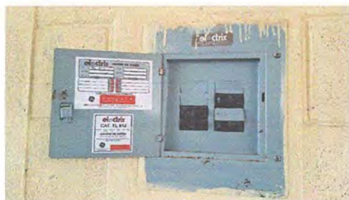
Foto 9: Módulo 1: Sustitución de flipones
