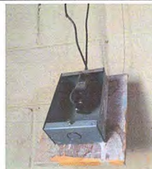
Foto 21: Módulo 2: Sustitución de tablero y caja de flipones
