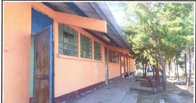
Foto: 4 Modulo 1 Suministro e instalacion de balcones
