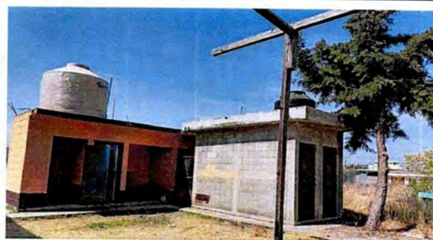
Foto: 8 Modulo 2 Sustitucion de deposito de agua
