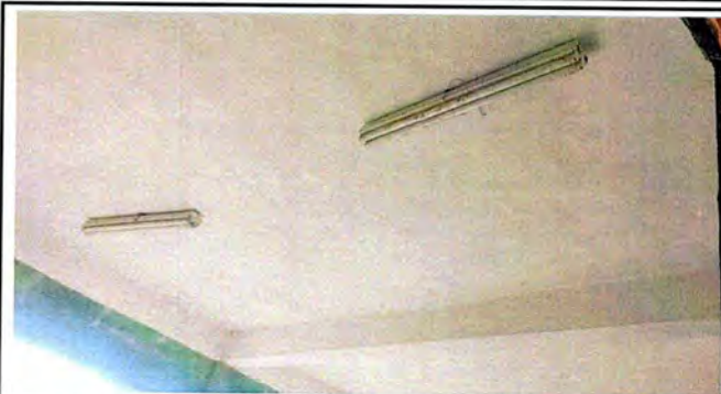
Foto: 7 Modulo 2 Sustitucion de focos ahorrables
