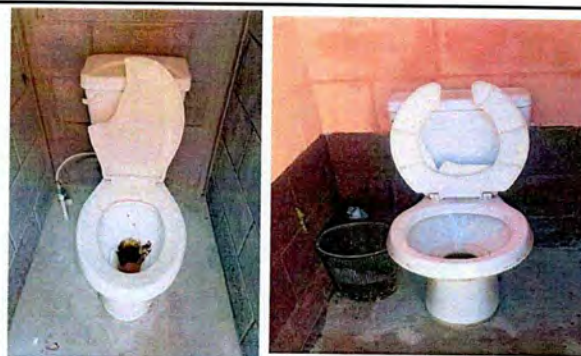
Foto: 10 Modulo 3 Sustitucion de inodoros
