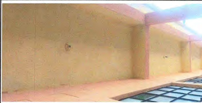
Foto : 3 Modulo 1 Sustitucion de focos ahorrables
