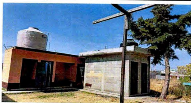
Foto: 11 Modulo 3 Sustitucion de Deposito de Agua
