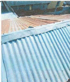
Foto1: Módulo 1. Sustitución de lámina por lámina troquela aluzinc calibre 26
