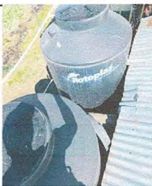
Foto 3: Módulo 1: Sustitución de depósito de agua de 1,700 litros, y Sustitución de tubería PVC.
