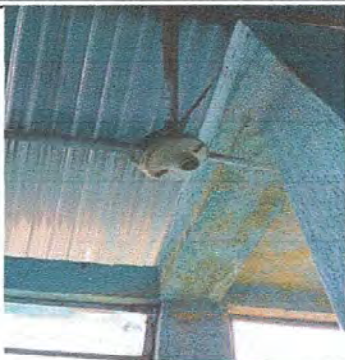
Foto 7: Módulo 1. Sustitución de plafoneras. Sustitución de focos led. Cableado eléctrico y ducto eléctrico + accesorios.
