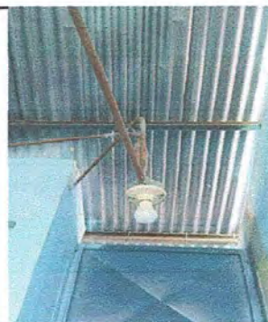
Foto6: Módulo 1. Sustitución de plafoneras. Sustitución de focos led. Cableado eléctrico y ducto eléctrico + accesorios.
