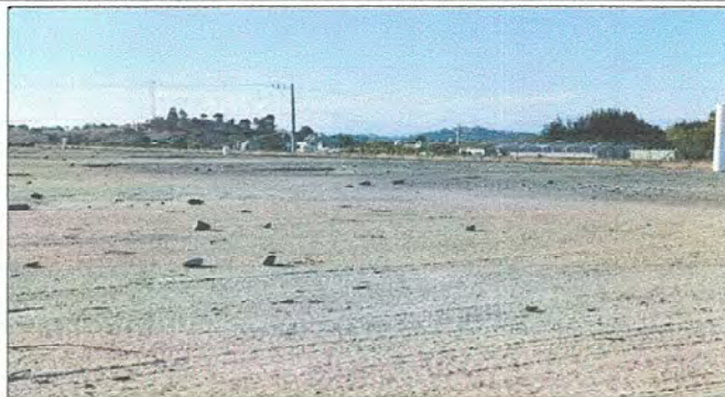
Foto 8: Módulo 2. Reparación de pañuelos.
