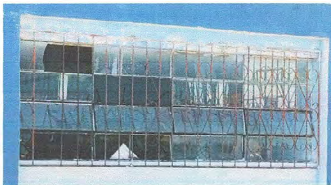
Foto 10: Módulo 3. Sustitución de vidrios
