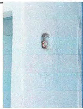
Foto 4: Módulo 1. Sustitución de llave de paso.
