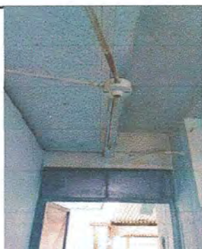
Foto 5: Módulo 1. Sustitución de plafoneras. Sustitución de focos led. Cableado eléctrico y ducto eléctrico + accesorios.
