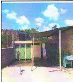
Foto 10: MODULO 3, Sustrución de lámina, por lámina troquelada aluzinc calibre 26, Sustrución de estructura de soporte de madera, por metal
