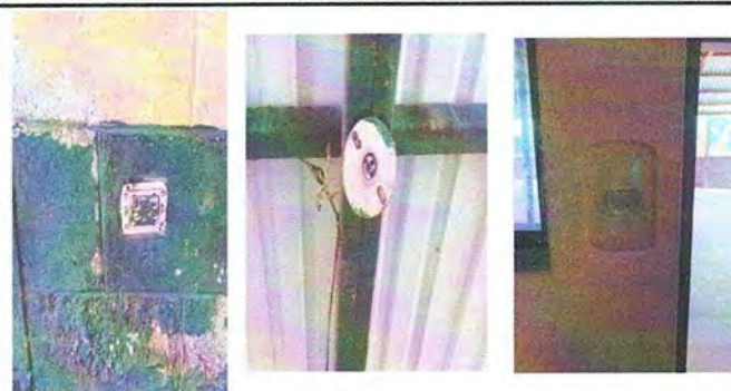
Foto 4: MODULO 1, Sustitución de plafoneras, Sustitución de tomacorrientes dobles, Sustitución interruptores simples, Sustitución interruptores dobles, Reparación de cableado electrico, Sustitución de ducto eléctrico + accesorios.
