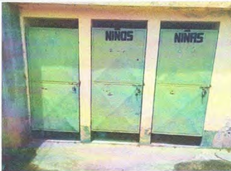
Foto 15: MODULO , Mantenimiento a estructura de puerta (lijado, cambio de tubo , cepillado, sujeciones, aplicación de pintura) a puertas servicios sanitarios
