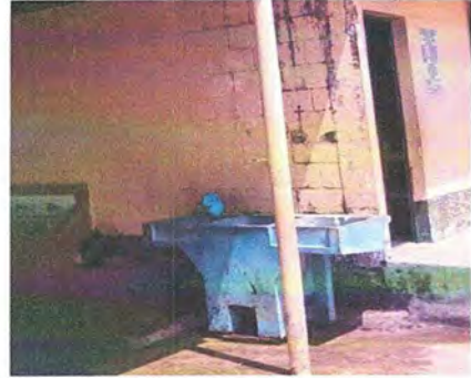
Foto 14: MODULO 3, Reparación de base de concreto de pila, Instalación de tubería PVC para aguas negras, Instalación de tubería PVC para aguas negras
