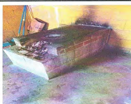
Foto 8: MODULO 2, Instalación de azulejo en estufa rural
