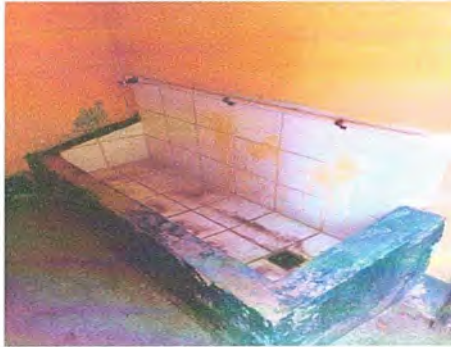
Foto 13: MODULO 3, Sustitución de mingitorio
