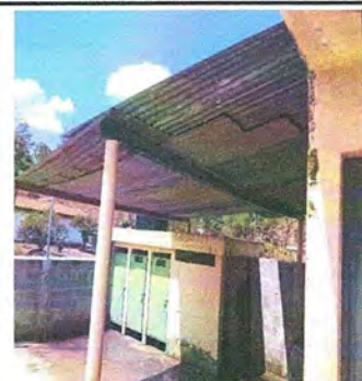
Foto 10: MODULO 3, Sustrución de lámina, por lámina troquelada aluzinc calibre 26, Sustrución de estructura de soporte de madera, por metal
