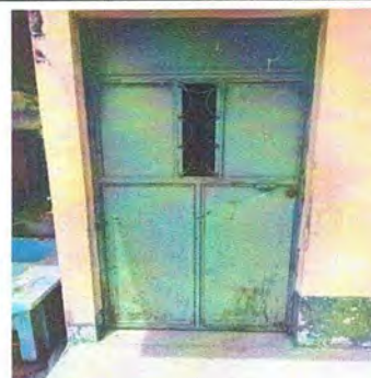
Foto 6: MODULO 2, Mantenimiento a estructura de puerta (lijado, cambio de tubo, cepillado, sujeciones, aplicación de pintura)
