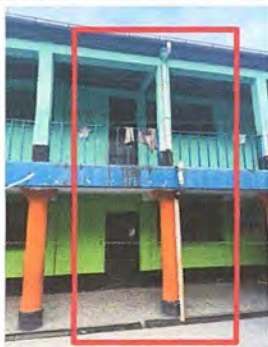
Foto 5: Sustitución de bajada de agua pluvial de PVC 3", en las aulas del segundo nivel, por estar en una altura grande es necesario varios codos y mas materiales.
