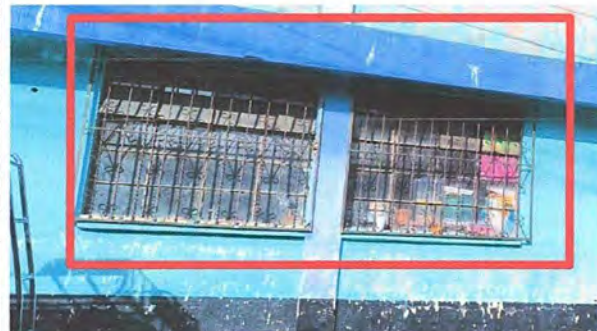
Foto 2: Mantenimiento de balcones de metal.
