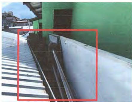
Foto 7: Sustitución de baranda de metal.
