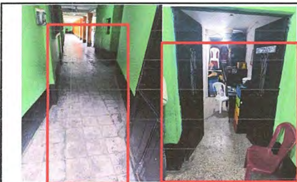
Foto 3: Cambio de piso de granito por cerámico, en la entrada de acceso al instituto y una bodega pequeña.
