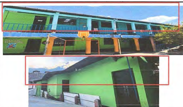
Foto 4: sustitución de canal de metal en las aulas del segundo nivel
