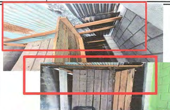
Foto 8: Sustitución de lámina, por lámina troquelada aluzinc.
