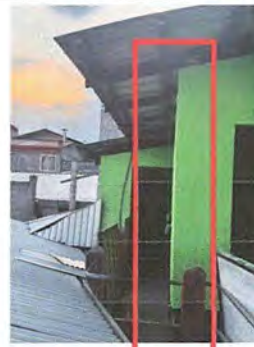
Foto 6: Sustitución de bajada de agua pluvial de PVC 3", en las aulas del segundo nivel, por estar en una altura grande es necesario varios codos y parales de metal para sostener los tubos.
