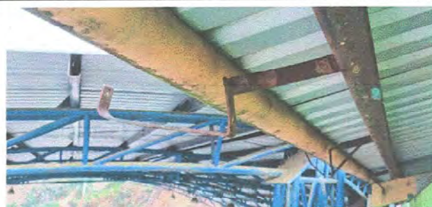
Foto 8: Modulo 4. Sustitución de soporte o pezcante de metal para canal
