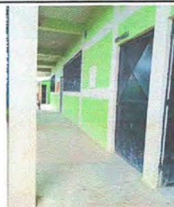
Foto 4: Módulo 4: Sustitución de piso
