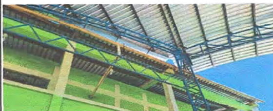
Foto 5: Módulo 4. Sustitución de canal de PVC.
