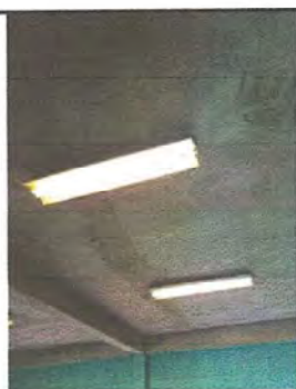
Foto 12: Módulo 4. Sustitución de lámparas tipo LED
