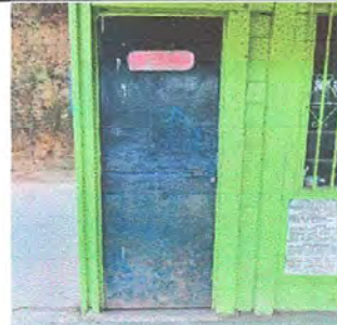
Foto 2: Módulo 2 Sustitución de puerta.
