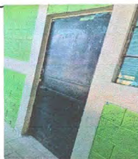
Foto 3: Módulo 4: Sustitución de puerta.
