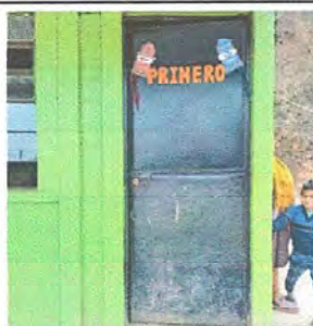
Foto 1: Módulo 1. Sustitución de puerta.
