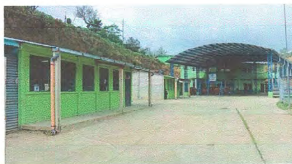
Foto 13. Pintura General. Pintura en muros exteriores e inferiores
