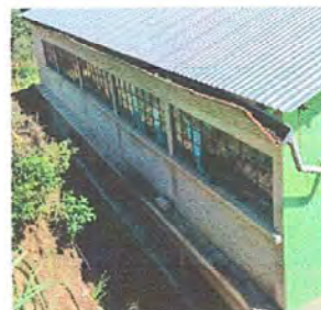
Foto 6: Módulo 4. Sustitución de canal de metal a PVC tipo caudal
