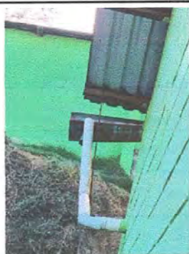
Foto 10. Modulo 4: Sustitución de bajada de agua pluvial
