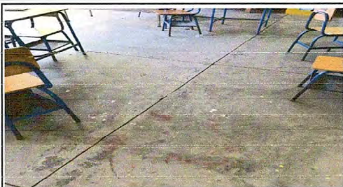
Foto 1: Módulo 1: Sustitución de piso de torta de concreto por piso cerámico
