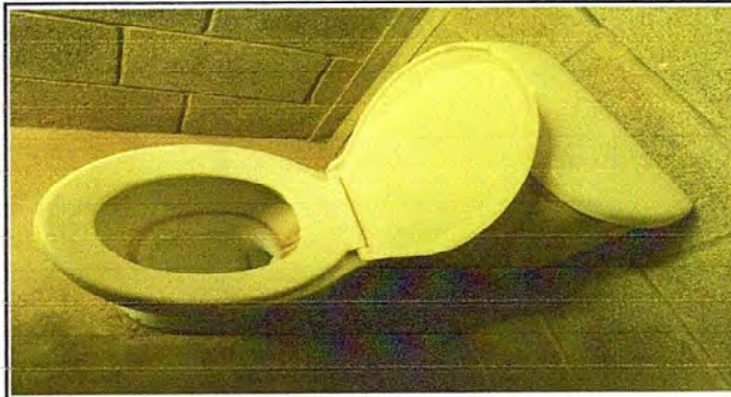
Foto 4: Módulo 2: Sustitución inodoro
