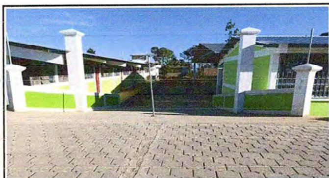
Foto 5: Muro Perimetral: Suministro e instalación de portón de metal de ingreso
