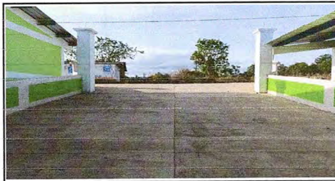
Foto 6: Muro Perimetral: Suministro e instalación de portón de metal de ingreso
