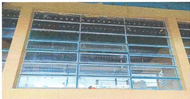
Foto 1: Módulo 1. Suministro e instalación de balcon de hierro en ventana.
