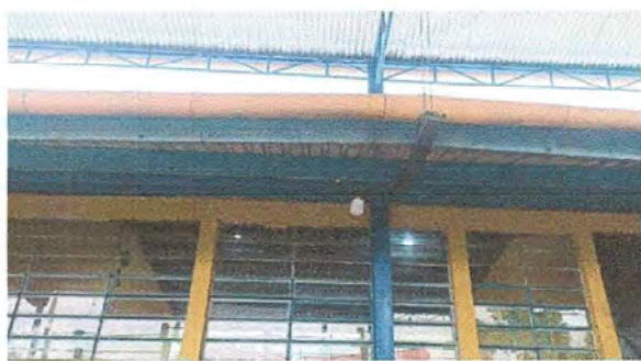
Foto 3: Módulo 1. Sustitución de canal pvc.
