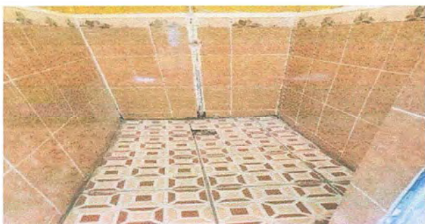
Foto 7: Módulo 1 Instalación de inodoro
