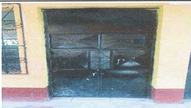
Foto 5: Módulo 1. Sustitución de puerta de metal.
