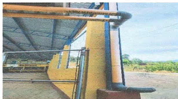
Foto 4: Módulo 1. Reparación de bajada de agua pluvial, tuvo PVC 3.
