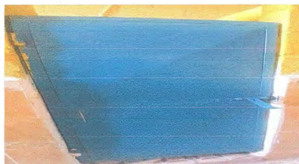
Foto 8: Módulo 1 Mantenimiento a estructura de puerta aplicación de pintura.
