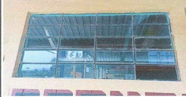
Foto 2: Módulo 1. Sustitución de vidrios.
