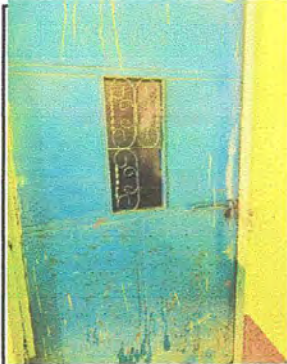
Foto 1: Sustrucción de puertas de metal en los 3 módulos por deterioro.
