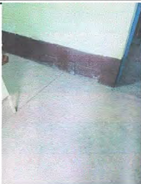
Foto1: Sustitución de piso torta de concreto por piso cerámico Módulo No. 4
