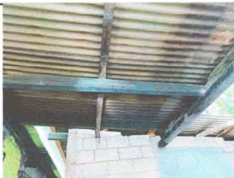
Foto 5: Sustrucción de lámina por lámina troquelada aluzinc calibre 26
