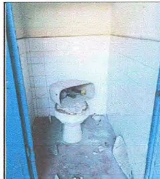
Foto 2: Sustrucción de inodoros en módulo No. 1
