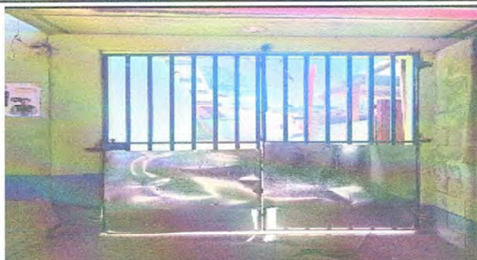
Foto 1: Muro perimetral. Sustitución de portón de metal (1.72 x 2.40)
