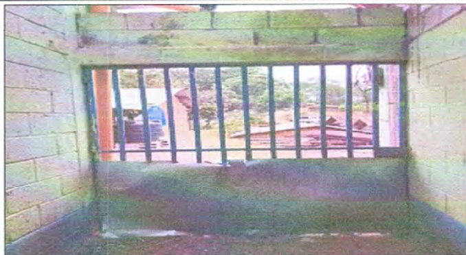
Foto 2: Muro perimetral. Sustitución de portón de metal (1.51 x 2 metros)
