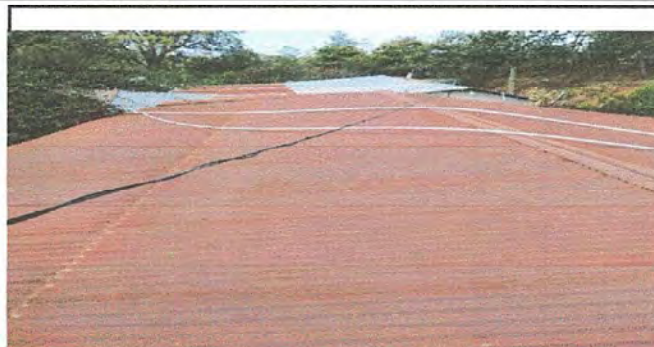
Foto 2: modulo 1, Sustitución de láminas por láminas troqueladas aluzinc cal26
