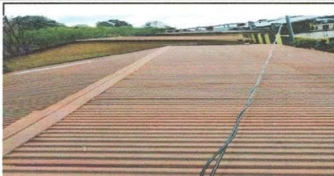
Modulo 1. Sustitución de láminas por láminas troqueladas aluzinc cal.26
