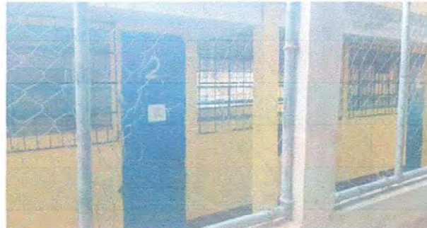
Foto 6: Modulo 4 Reparación de tubo hg y malla galvanizada.
