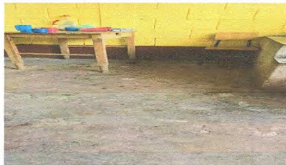
Foto 4: Modulo 2 Sustitución de piso de granito.
