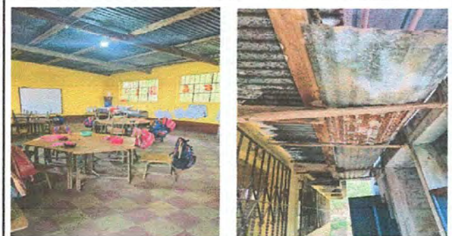
Foto 3: Modulo 1 sustitución de estructuras de soporte de madera por metal
