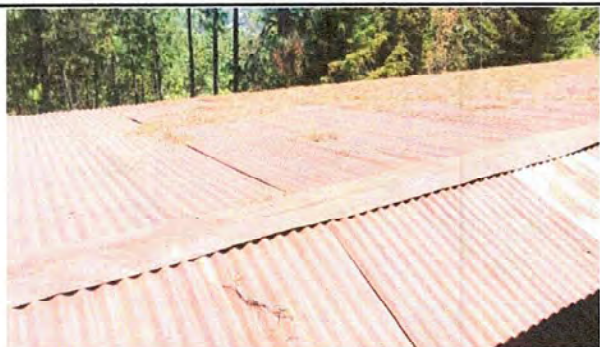
Foto1: Modulo 1: Sustitución de lámina por lámina troquelada aluzinc calibre 26, sustitución de capote y sustitución de elementos de fijación.
