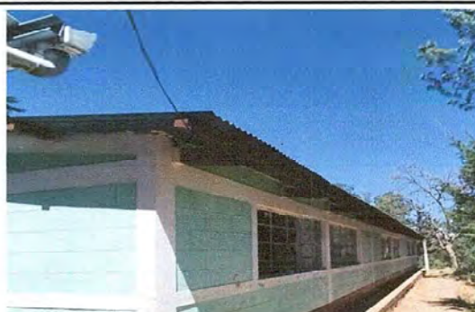
Foto 2: MODULO 1: Sustitución de canal de pvc y bajadas de agua pluvial.
