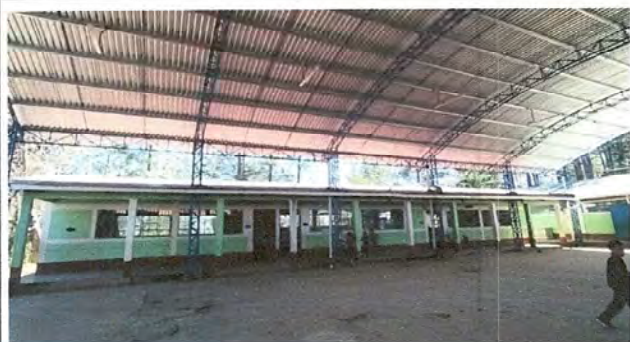
Foto 5: PINTURA GENERAL: Pintura de muros interiores y exteriores.
