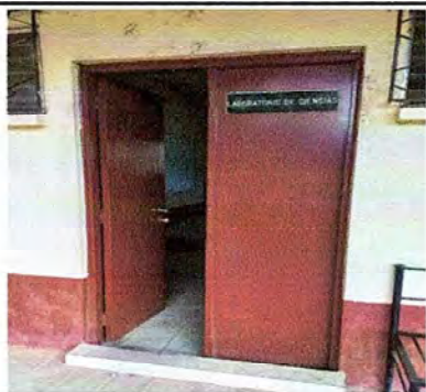
Foto 9: Modulo 4, Sustitución de Puerta de doble hoja
