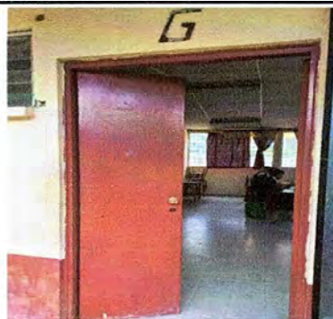
Foto 10: 4, Sustitución de Puerta de doble hoja
