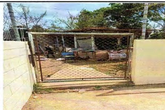
Foto 14: Modulo Abierto, Sustitución de Puerta de doble hoja
