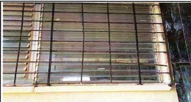
Foto13: Modulo 4 Sustitución de Balcon de Metal
