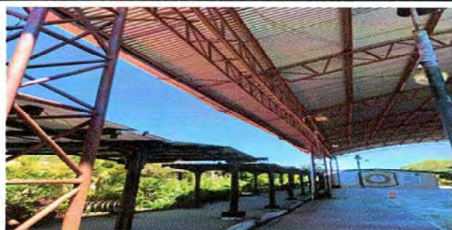
Foto 15: Modulo Abierto, Mantenimiento a Estructura de Soporte de Metal
