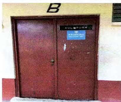
Foto 3: Modulo 2, Sustitución de Puerta de doble hoja
