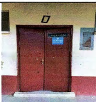
Foto 5: Modulo 2, Sustitución de Puerta de doble hoja
