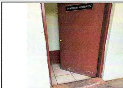
Foto 7: Modulo 4, Sustitución de Puerta de una hoja
