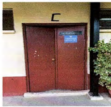
Foto 4: Modulo 2, Sustitución de Puerta de doble hoja
