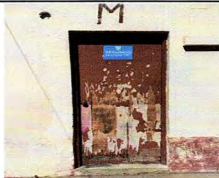
Foto 2: Modulo 1, Sustitución de Puerta de una hoja
