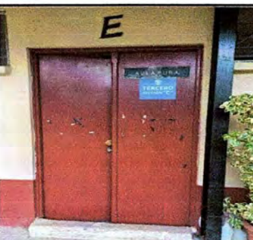
Foto 6: Modulo 2, Sustitución de Puerta de doble hoja
