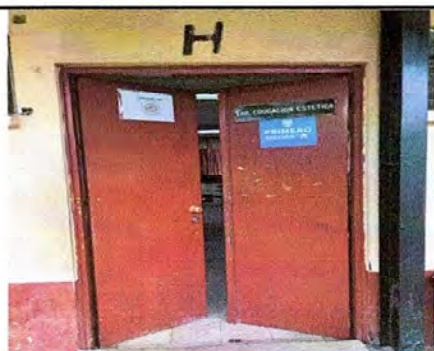
Foto 11: Modulo 4, Sustitución de Puerta de doble hoja
