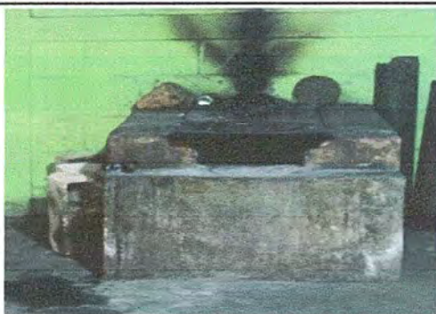
Foto 3: MODULO 1: SUSTITUCIÓN DE ESTUFA MEJORADA COMPLETA (INCLUYE PLANCHA, CHIMIINEA)
