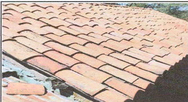
Foto1: Modulo 1: SUSTITUCION DE TEJA, POR LAMINA TROQUELADA ALUZINC CALIBRE 26
