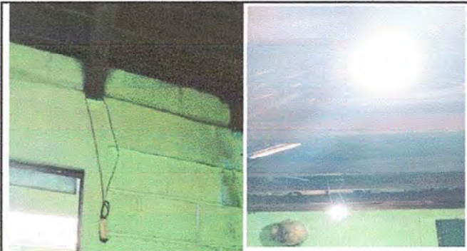
Foto 4: MODULO 1: SUSTITUCIÓN DE FOCOS AHORRADORES, SUSTITUCIÓN DE PLAFONERA, SUSTITUCIÓN DE INTERRUPTORES, SUSTITUCIÓN DE TOMACORRIENTES Y REPARACIÓN DE CALBEADO ELECTRICO.
