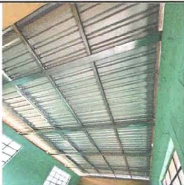
Foto1: Módulo 1: Suministro de: plafoneras, focos, cables, tomacorriente, apagadores
