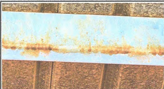
Foto 3: Modulo 2: Sustitución de estructura de soporte de metal, por metal
