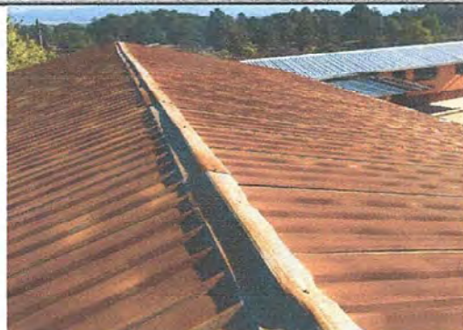
Foto 4: Módulo2: Sustitución de capote de lámina por lámina troquelada
