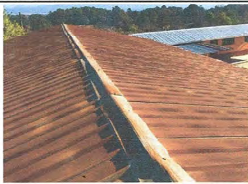
Foto 2: Modulo1: Sustitución de lámina, por lamina troquelada aluzinc calibre 28
