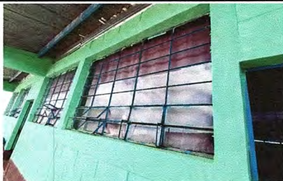
Foto 2: MODULO 1: Suministro e instalacion de balcones de 4 aulas.
