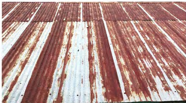
Foto 1: MODULO 1: Sustitución de laminas, por lamina troquelada para 2 aulas y un graderio.
