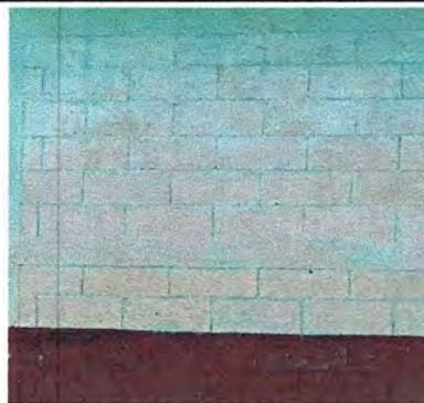
Foto 4: MODULO 1: Sustitución de pintura en muros interiores de 2 aulas.
