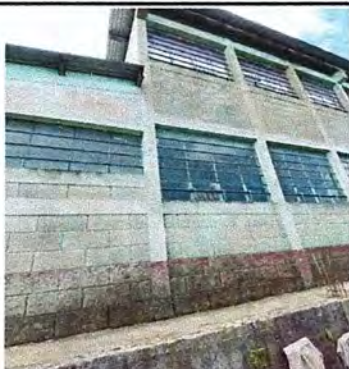
Foto 3: MODULO 1: Sustitución de pintura en muros exteriores 4 aulas.
