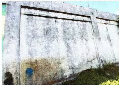
Foto 6: MODULO 2: Sustitución de pintura en muros exteriores de 2 aulas.
