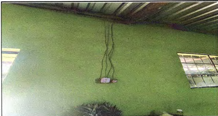
Foto 13: MODULO 2 SUSTITUCIÓN DE INTERRUPTORES DOBLES
