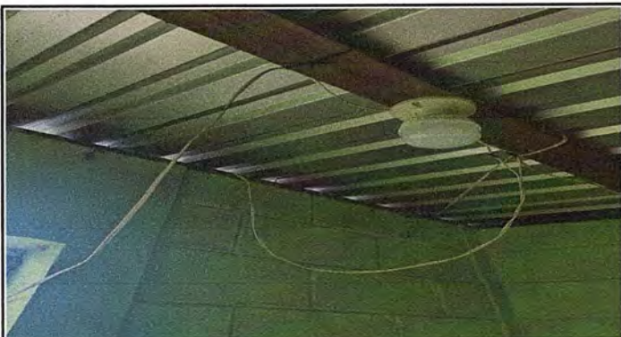
Foto 9: MODULO 2 SUMINISTRO DUCTO ELECTRICO + ACCESORIOS
