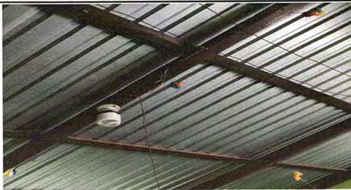
Foto 7: MODULO 1 SUSTITUCIÓN DE FOCOS AHORRADORES
