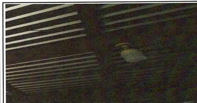
Foto 35: MODULO 4 SUSTITUCIÓN DE FOCOS AHORRADORES
