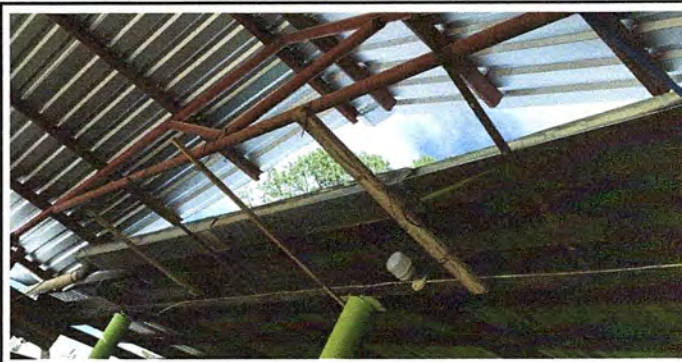
Foto 18: MODULO 2 SUSTITUCIÓN DE CANAL DE METAL
