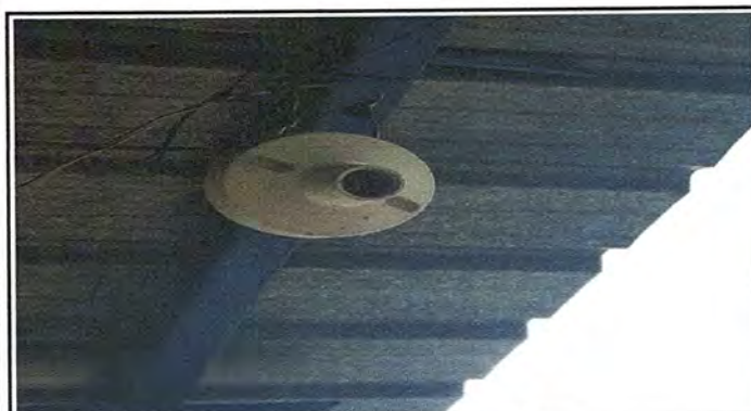
Foto 33: MODULO 4 SUSTITUCION DE PLAFONERAS
