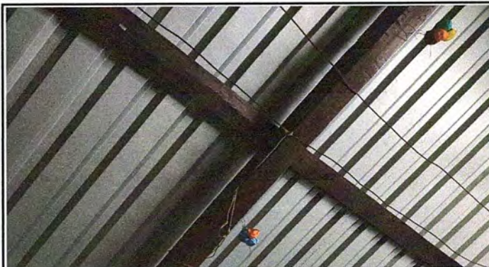
Foto 2: MODULO 1 SUMINISTRO DUCTO ELECTRICO + ACCESORIOS
