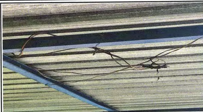
Foto 32: MODULO 4 SUMINISTRO DUCTO ELECTRICO + ACCESORIOS
