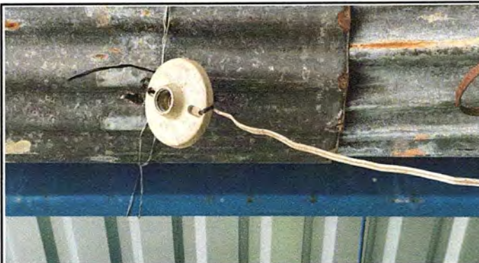
Foto 10: MODULO 2 SUSTITUCION DE PLAFONERAS
