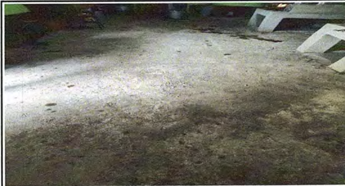
Foto 26: MODULO 3 SUSTITUCIÓN DE PISO DE TORTA DE CONCRETO POR PISO CERAMICO
