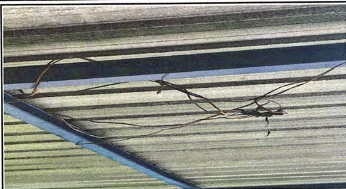
Foto 31: MODULO 4 REPARACIÓN DE CABLEADO ELECTRICO
