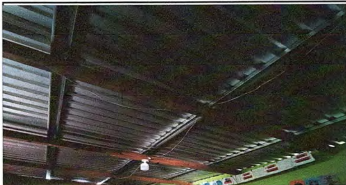
Foto1: MODULO 1 REPARACIÓN DE CABLEADO ELECTRICO
