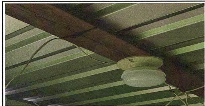
Foto 17: MODULO 2 SUSTITUCIÓN DE FOCOS AHORRADORES
