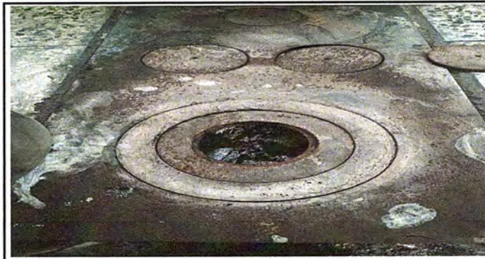
Foto 30: MODULO 3 SUSTITUCIÓN DE PLANCHA DE METAL DE 3 HORNILLAS
