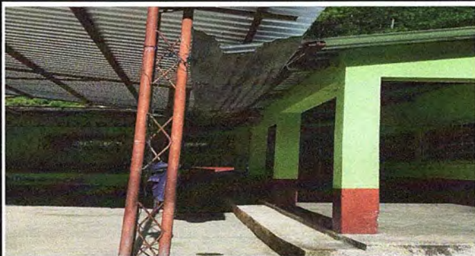
Foto 19: MODULO 2 SUSTITUCIÓN DE BAJADA DE AGUA PLUVIAL TUVO PVC 3
