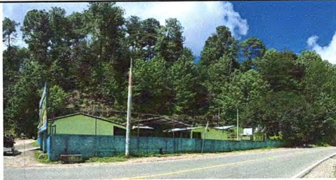
Foto 36: PINTURA EN MUROS EXTERIORES E INTERIORES
