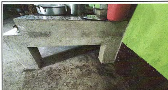
Foto 27: MODULO 3 INSTALACIÓN DE AZULEJO EN ESTUFA RURAL
