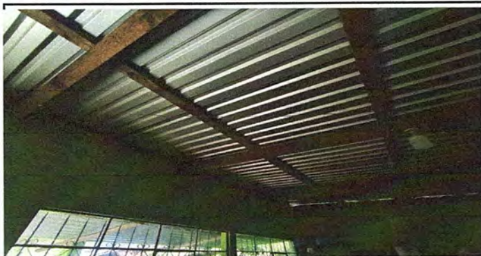
Foto 25: MODULO 3 SUSTITUCIÓN DE FOCOS AHORRADORES
