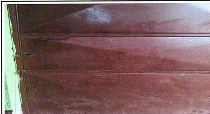
Foto 28: MODULO 3 SUSTITUCIÓN DE CHAPA
