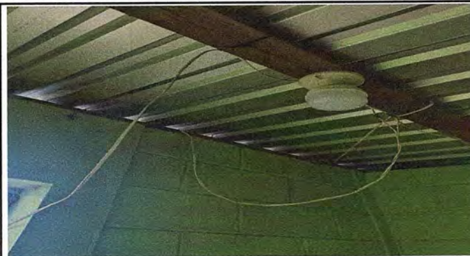
Foto 8: MODULO 2 REPARACIÓN DE CABLEADO ELECTRICO
