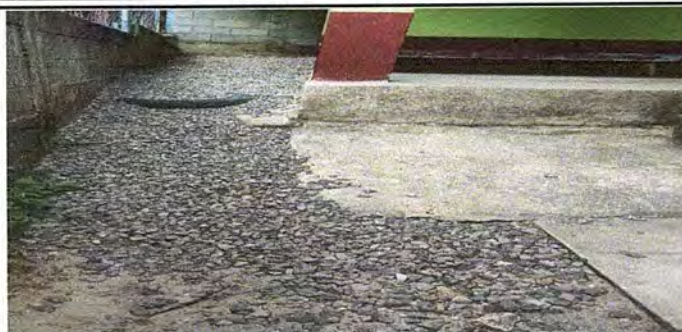
Foto 37: PATIO REPARACIÓN DE BANQUETA DE CONCRETO
