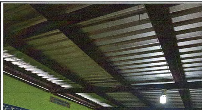
Foto 21: MODULO 3 SUMINISTRO DUCTO ELECTRICO + ACCESORIOS
