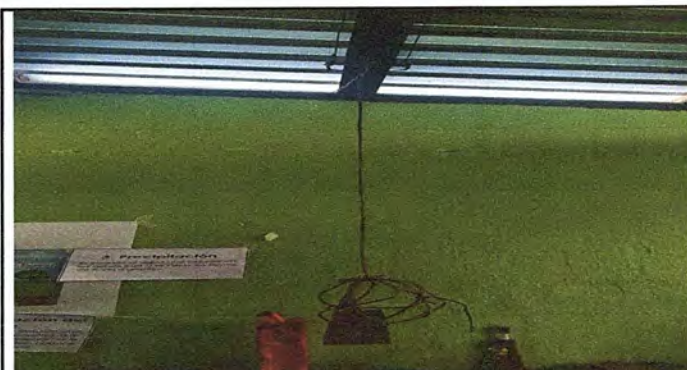
Foto 4: MODULO 1 SUSTITUCIÓN DE TOMACORRIENTES
