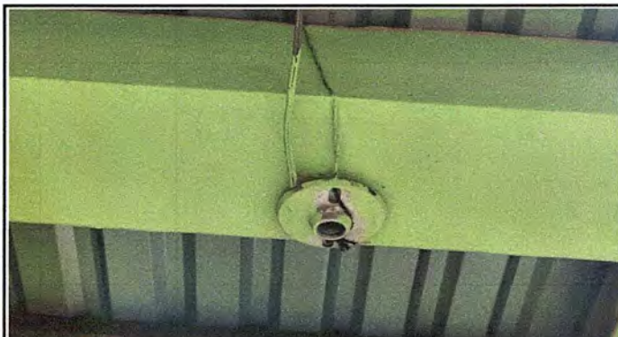
Foto 22: MODULO 3 SUSTITUCION DE PLAFONERAS
