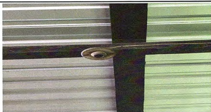
Foto 3: MODULO 1 SUSTITUCION DE PLAFONERAS
