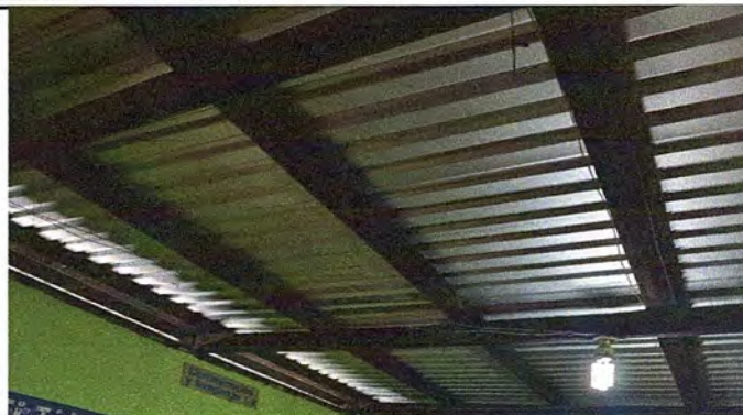
Foto 20: MODULO 3 REPARACIÓN DE CABLEADO ELECTRICO
