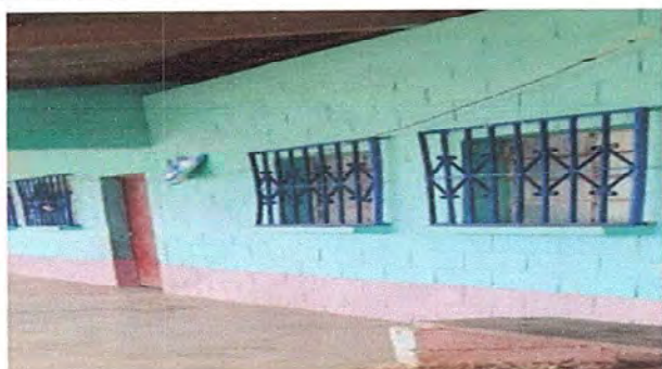
Foto 9: PINTURA GENERAL: Pintura en muros exteriores e interiores
