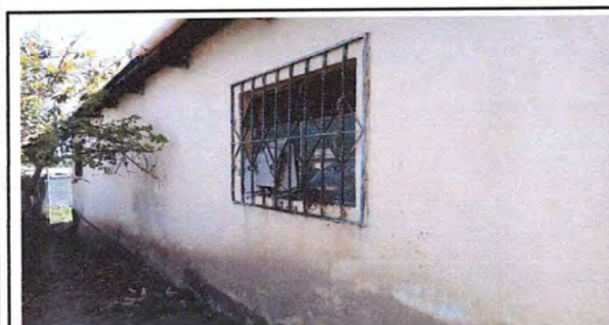
Foto 23: PINTURA GENERAL: Pintura en muros exteriores e interiores
