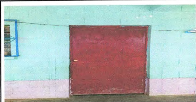
Foto 3: MÓDULO 1: Mantenimiento a estructura de puerta (lijado, cambio de tubo, cepillado, sujeciones aplicación de pintura)
