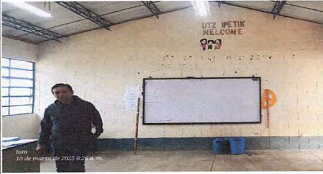
Foto 16: MÓDULO 2: Sustitución de piso de torta de concreto por piso cerámico
