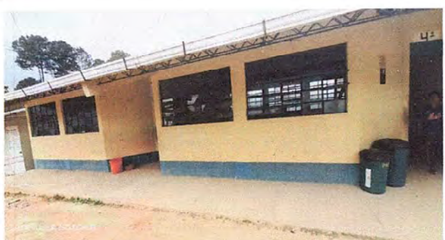
Foto 15: MÓDULO 2: Sustitución de piso de torta de concreto por piso cerámico
