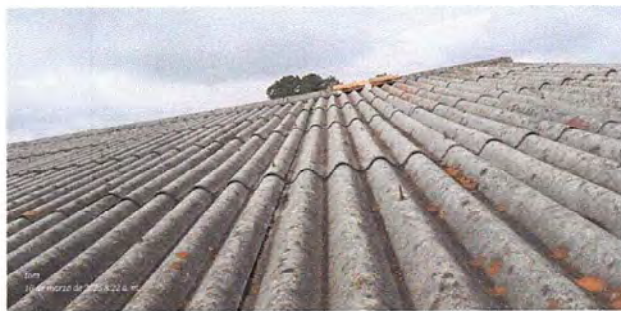
Foto 8: MÓDULO 1: Sustitución de capote de lámina para lámina troquelada
