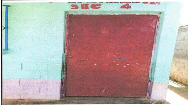
Foto 2: MÓDULO 1: Mantenimiento a estructura de puerta (lijado, cambio de tubo, cepillado, sujeciones aplicación de pintura)
