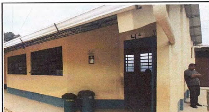
Foto 21: PINTURA GENERAL: Pintura en muros exteriores e interiores
