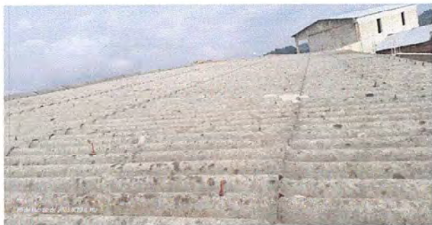
Foto 7: MÓDULO 1: Sustitución de lámina por lámina troquelada
