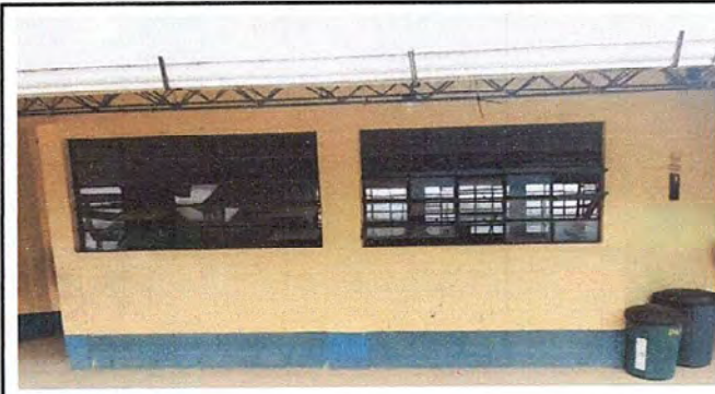
Foto 20: PINTURA GENERAL: Pintura en muros exteriores e interiores
