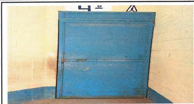
Foto 19: MODULO 2: Mantenimiento a estructura de puerta (lijado, cambio de tubo, cepillado, sujeciones aplicación de pintura)
