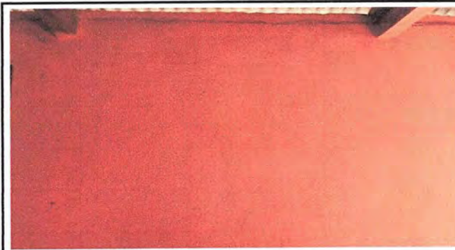
Foto 22: PINTURA GENERAL: Pintura en muros exteriores e interiores
