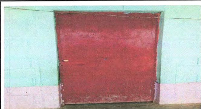
Foto 1: MÓDULO 1: Mantenimiento a estructura de puerta (lijado, cambio de tubo, cepillado, sujeciones aplicación de pintura)
