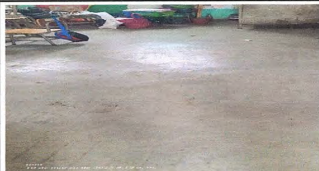
Foto 14: MÓDULO 2: Sustitución de piso de torta de concreto por piso cerámico
