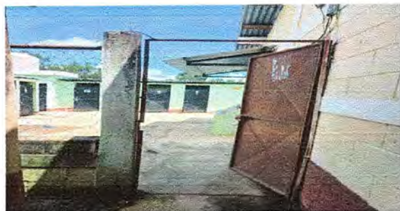
Foto 8: Muro perimetral: sustitución de puerta de metal en módulos 219m *107.5
