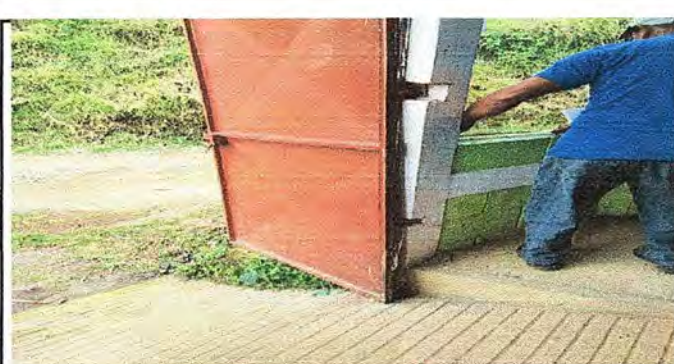
Foto 6: Muro perimetral: sustitución de puerta de metal en modulos 205 m *84.5
