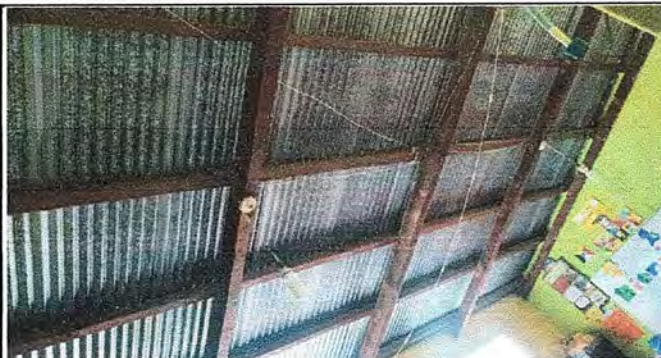
Foto 2: Módulo 1 -Sustitución de foco ahorrador
