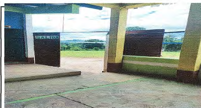
Foto 5: Muro perimetral: sustitución de porton de metal de ingreso 2.19 m *2.00
