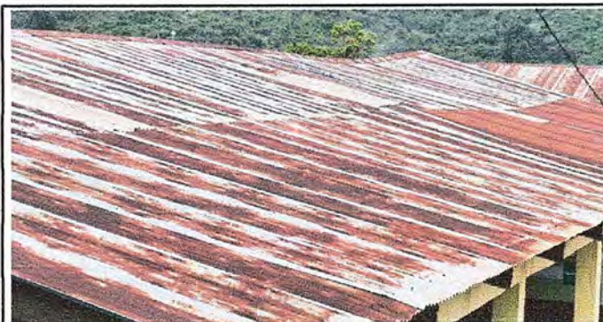
Foto 3: Módulo 2-Sustitución de lámina, por lámina troquelada aluzinc calibre 26.
