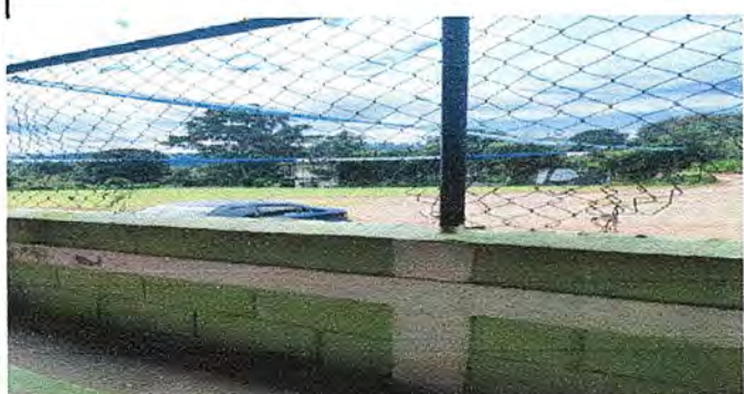
Foto 7: Muro perimetral: sustitución de malla por baranda de metal tipo reja
