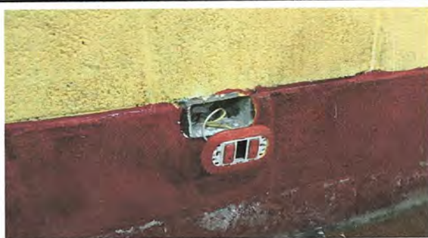
Foto 10. Módulo 3: sustitución de tomacorrientes dobles
