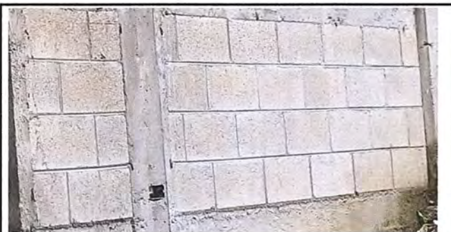
Foto 17. Módulo 4: Cernido en muro
