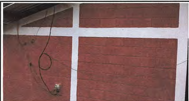
Foto 15. Módulo 3: reparación de cableado eléctrico.
