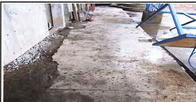
Foto 18. modulo 4. Sustitución de piso de torta de concreto por piso de cerámica
