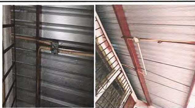
Foto 14. Módulo 3: Sustitución de focos ahorradores.
