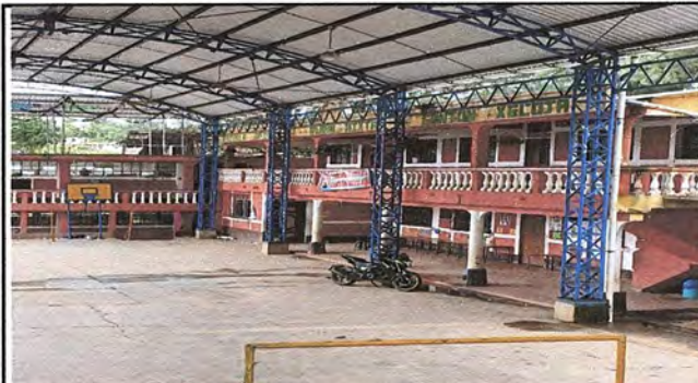
Foto 40. Pintura general. Pintura en muro exterior e interior
