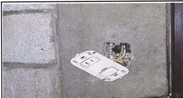
Foto 12. modulo 3: Sustitución de interruptores combinados
