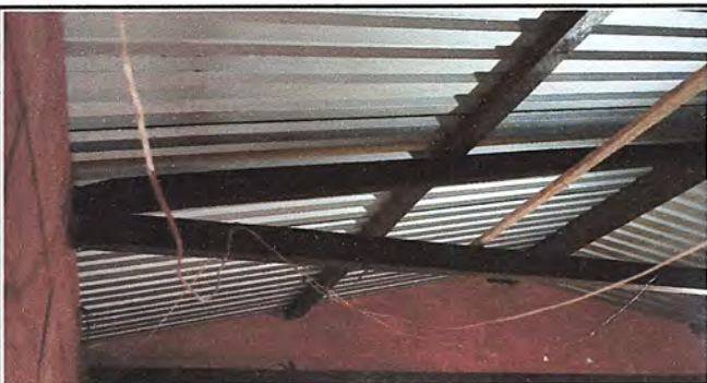
Foto 3. Módulo 1: reparación de cableado eléctrico.
