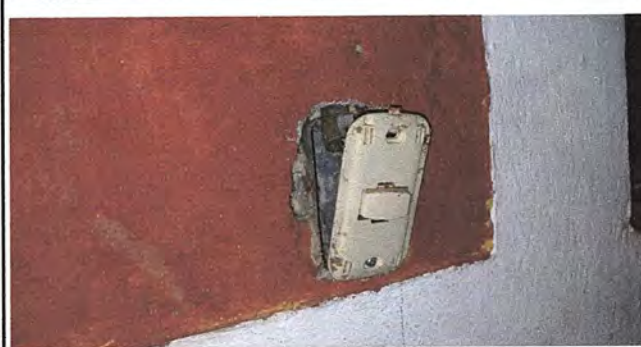
Foto 28. Módulo 5: Sustitución de interruptores simples
