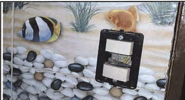
Foto 13 . Módulo 3: Sustitución de interruptores dobles
