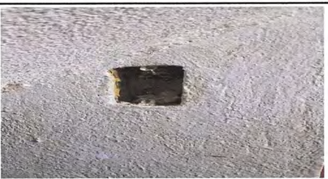
Foto 23. Módulo 4: Suministro de interruptor triple.
