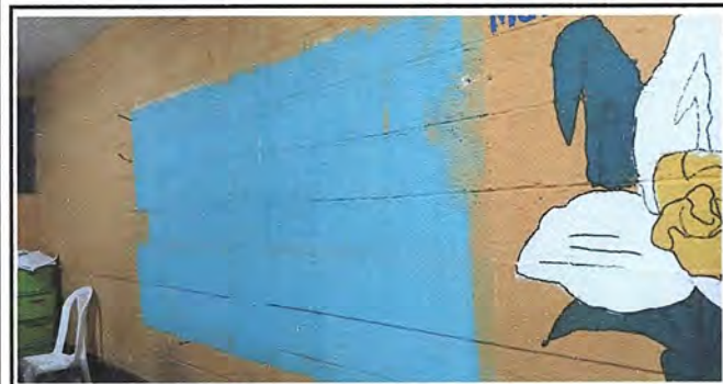
Foto 41. Pintura general. Pintura en muro exterior e interior
