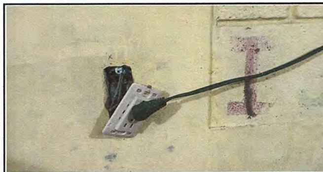
Foto 33. Módulo 6: Sustitución de tomacorrientes dobles.
