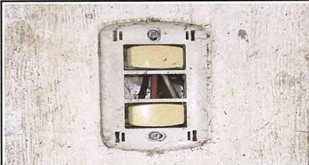
Foto 32. Módulo 6: Sustitución interruptores dobles
