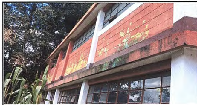
Foto 39: Pintura general: Pintura en muros exteriores e interiores.
