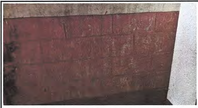
Foto 42. Pintura general. Pintura en muro exterior e interior
