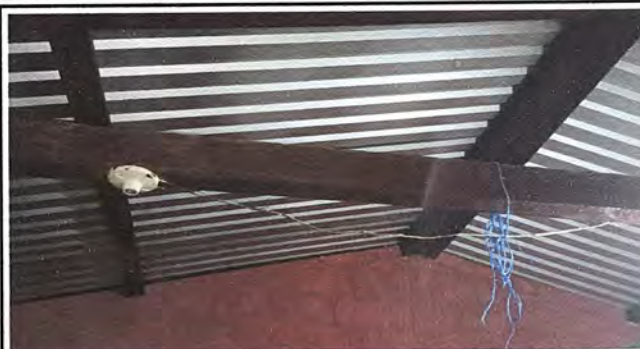
Foto 8. Módulo 2: Sustitución de cableado eléctricos y plafoneras
