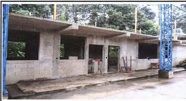
Foto 16. Módulo 4: Repello en muro y cernido en muro
