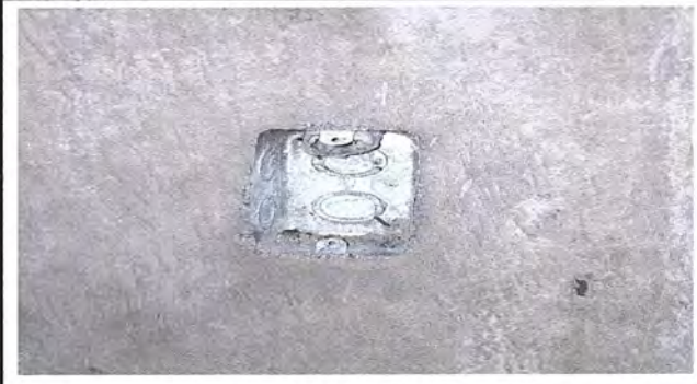
Foto 22. Módulo 4: Suministro de interruptor doble.
