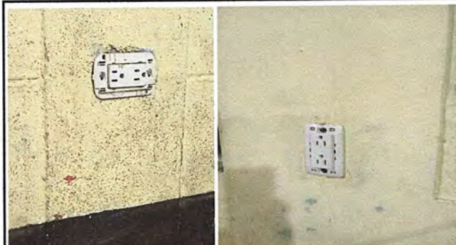
Foto 26. Módulo 5: Sustitución de tomacorrientes dobles.
