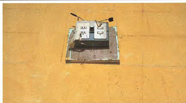
Foto 2. Módulo 1: Sustitución de tomacorrientes dobles e interruptores simples.
