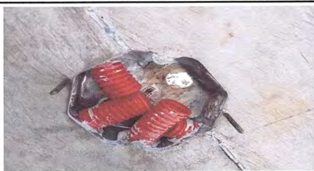
Foto 19. Módulo 4: Suministro de plafoneras.
