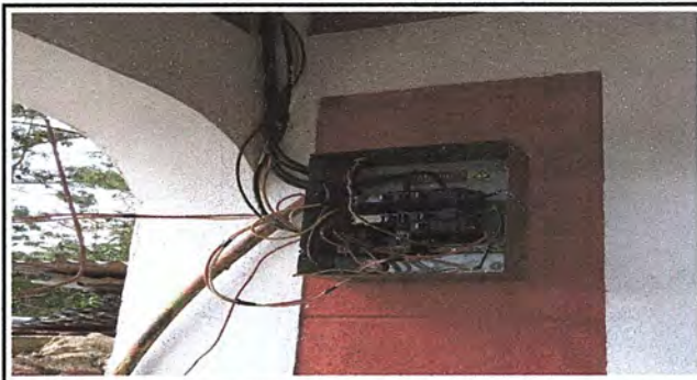
Foto 36. Módulo 6: Sustitución de tablero de flipones.
