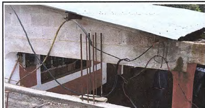
Foto 35. Módulo 6: reparación de cableado eléctrico
