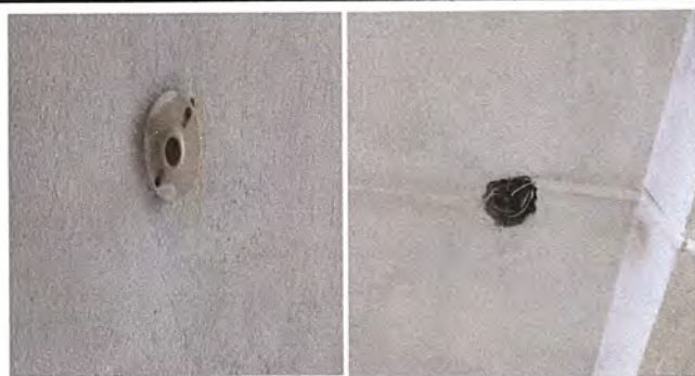
Foto 27. Módulo 5: Sustitución de plafoneras.
