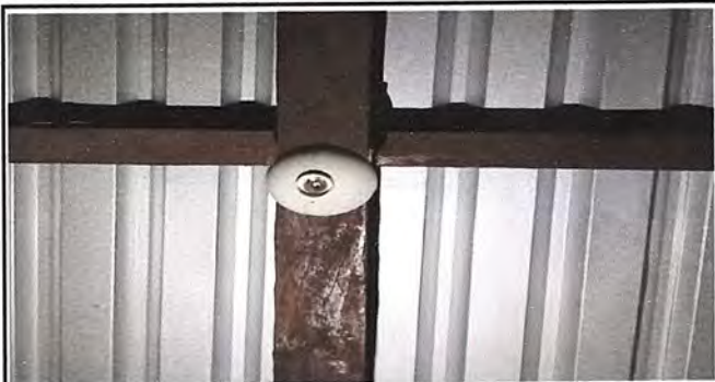
Foto 7. Módulo 2: Sustitución de plafoneras, reparación de cableado eléctrico y sustitución de focos ahorradores
