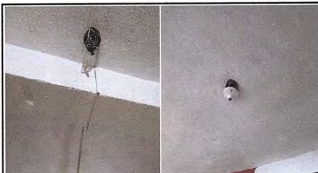
Foto 30. modulo 6: Sustitución de plafoneras.
