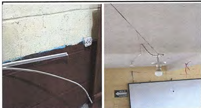
Foto 37. Módulo 6: Sustitución de ductos eléctricos.
