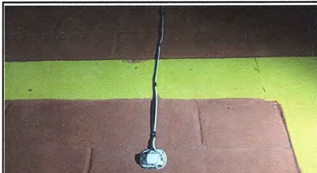
Foto 4. Módulo 1: Sustitución de interruptores simples.
