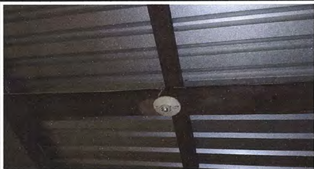
Foto 1. Módulo 1: Sustitución de plafoneras.
