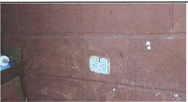
Foto 5. Módulo 2: Sustitución de tomacorrientes dobles.
