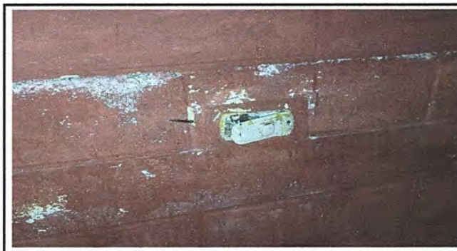
Foto 6. modulo 2. Sustitución de interruptores simples.
