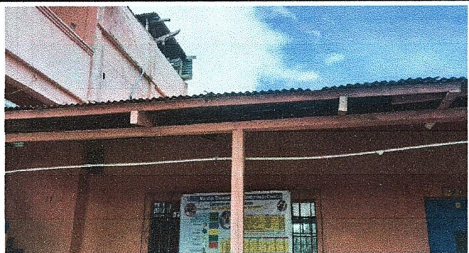
Foto 3: Módulo 1. Sustitución de canal de pvc
