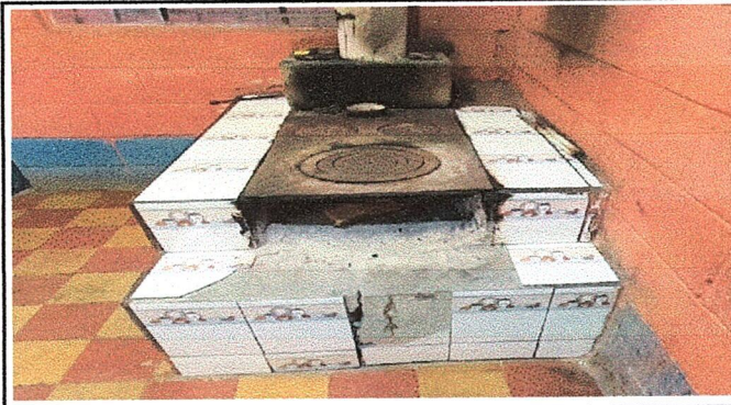
Foto 8: Módulo 1. Sustrucción de plancha de metal, chimenea de metal y instalación de azulejo en estufa rural
