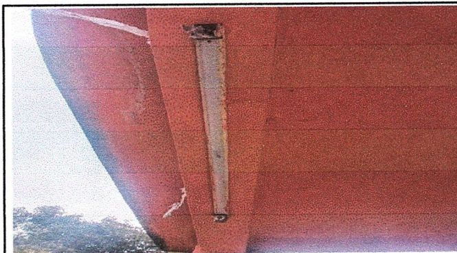
Foto 10: Módulo 2. Cambio de plafoneras y cambio de focos ahorradores
