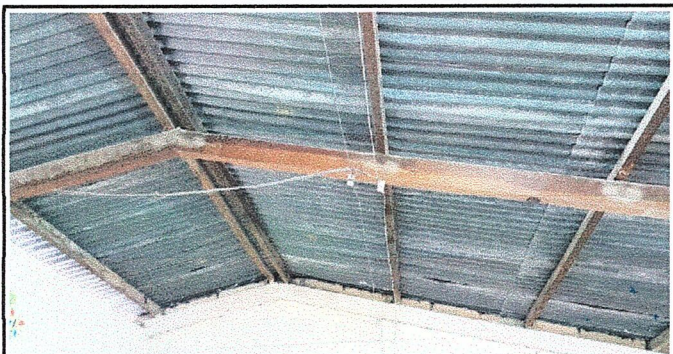
Foto 5: Módulo 1. Reparación de cableado eléctrico
