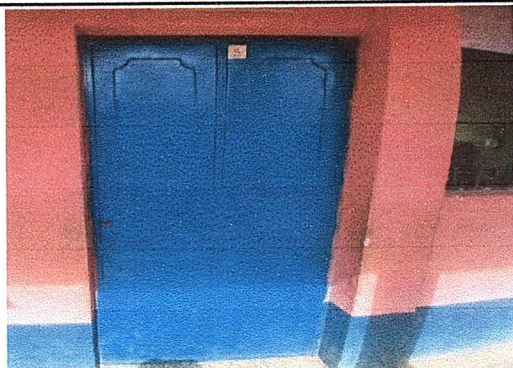
Foto 9: Módulo 2. Mantenimiento a estructura de puertas (lijado, cambio de tubo, cepillado, sujeciones, aplicación de pintura)
