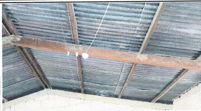
Foto 7: Módulo 1. Sustrucción de plafoneras y sustitución de focos ahorradores
