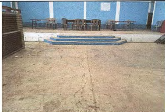
Módulo 1. 1: Sustitución de piso de torta de concreto a cerámico
