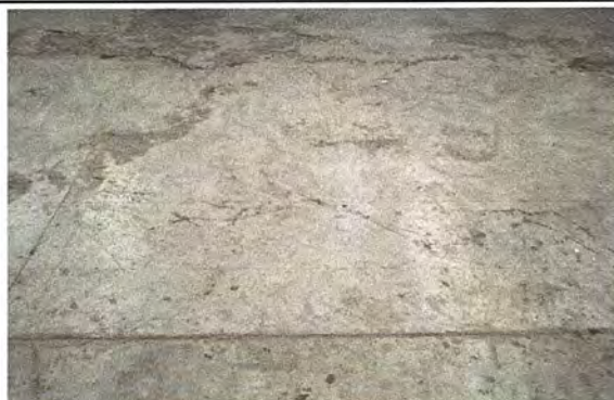
Módulo 1. 2: Sustitución de piso de torta de concreto a cerámico
