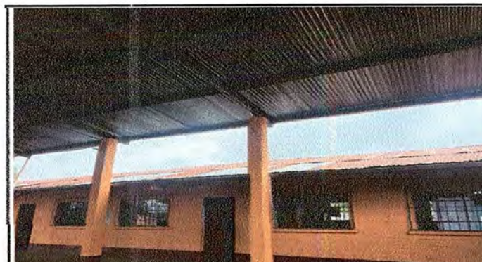
Foto 4: MODULO 3 Sustitución de lámina, por lámina troquelada aluzinc calibre 26
