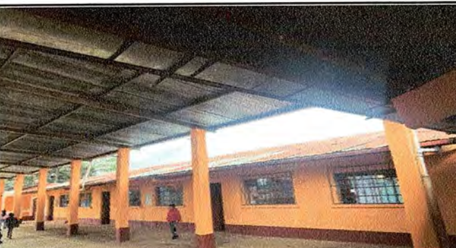
Foto 5: MODULO 3 Sustitución de canal de metal
