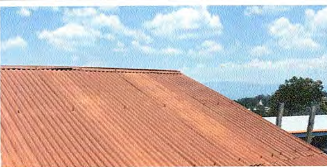
Foto 3: MODULO 2 Sustitución de capote de lámina para lámina troquelada
