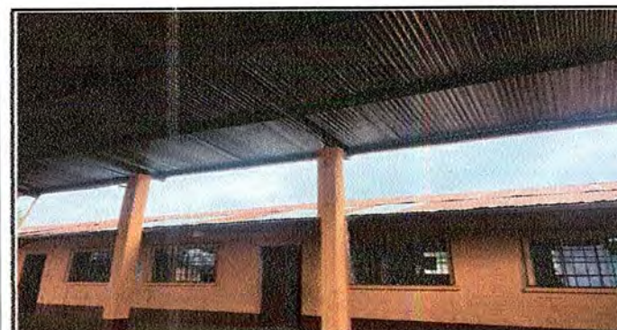
Foto 6: MODULO 3 Sustitución de capote de lámina para lámina troquelada
