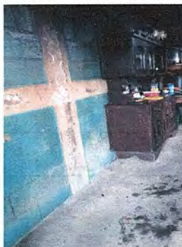
Foto 3: Módulo II. Repello de muro
