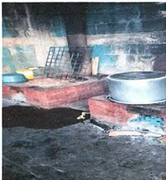
Foto 1: Módulo I. Instalación de azulejo en estufa rural
