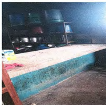
Foto 4: Módulo I. Suministro e instalación de azulesjos
