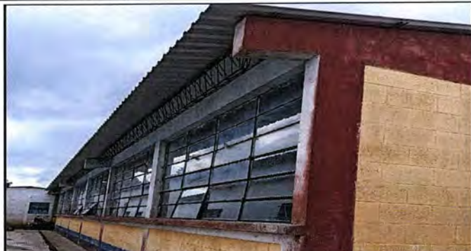
Foto1: MODULO 1: Suministro e instalación de balcones de metal
