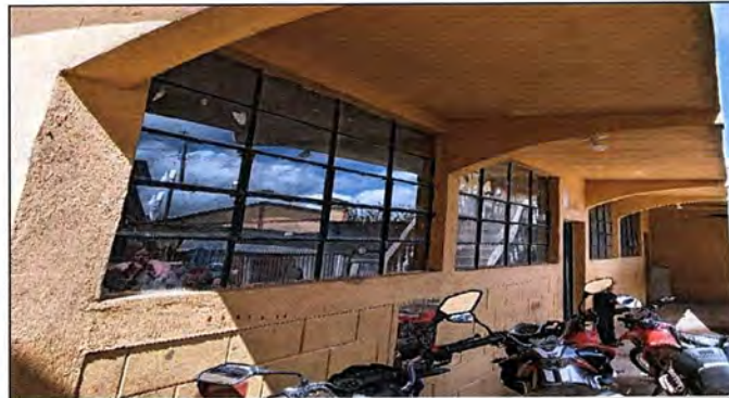
Foto 4: MODULO 5: Suministro e instalación de balcones de metal
