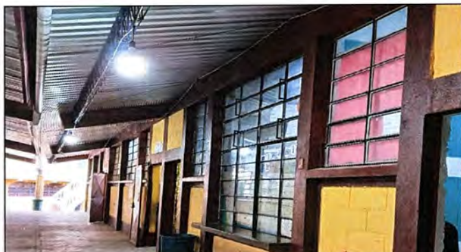
Foto 3: MODULO 4: Suministro e instalación de balcones de metal
