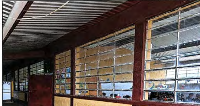
Foto 2: MODULO 3: Suministro e instalación de balcones de metal
