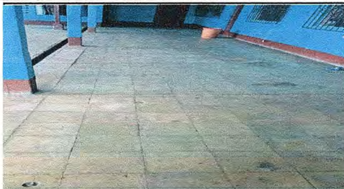
Foto 2: Módulo 1 Sustrucion de piso de granito por piso cerámico
