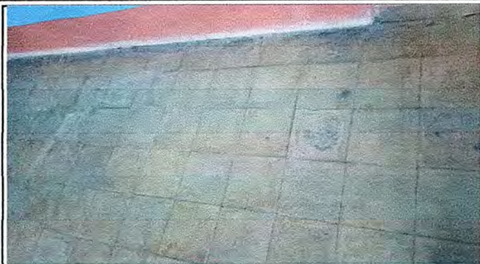
Foto1: Módulo 1 Sustrucion de piso de granito por piso cerámico
