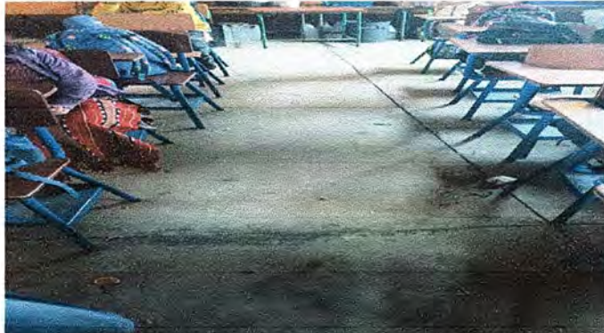
Foto 4: Módulo 2 Sustrución de torta de cocreto por piso cerámico
