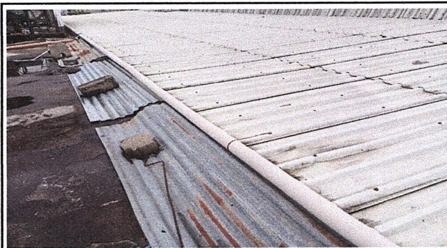
Foto 4: Cancha polideportiva, Sustitución de canaletas de PVC por PVC.
