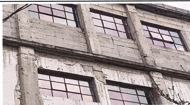
Foto 2: Módulo 3 Fabricación e instalación de balcón hierro en ventana.
