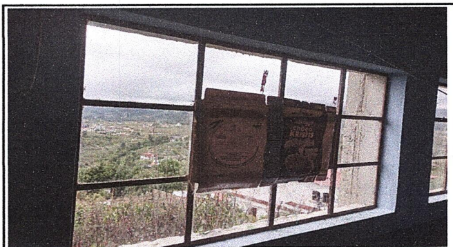
Foto 3: Módulo 3. Sustitución de ventanas de metal, por ventanas PVC.
