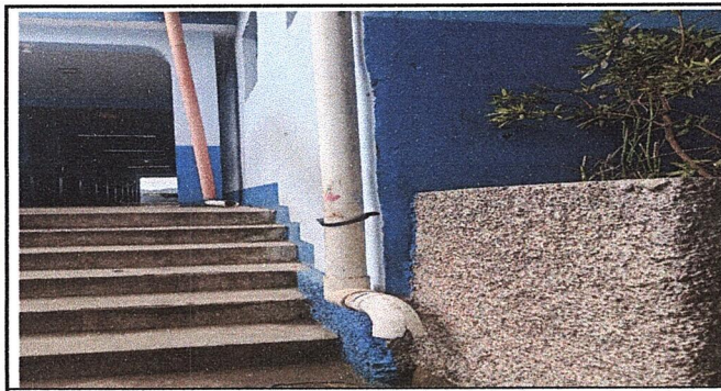
Foto 5: Cancha polideportiva. Reparación de bajada de agua pluvial tubo PVC de 3c.
