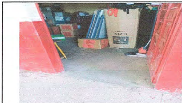
Foto 7: Módulo 2 Sustitución de piso de concreto a piso cerámico.
