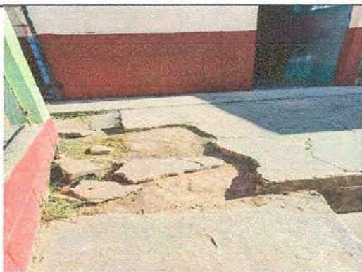
Foto 9: Módulo 2 Reparación de piso de torta de concreto
