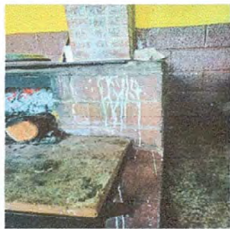
Foto1: Módulo 1. Sustrucción de estufa rural completa Incluye chimenea y plancha de metal
