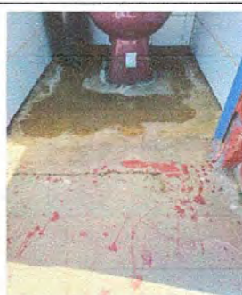
Foto 6: Módulo 2. Sustrucción de piso de torta de concreto a piso antideslizante.
