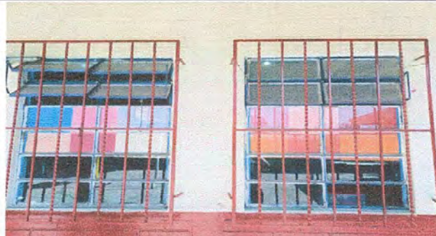
Foto 4: Módulo 2 Sustrucción de ventana de metal y mantenimiento a balcones de metal.
