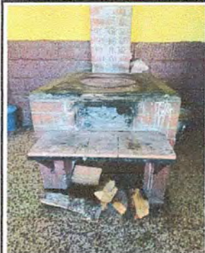
Foto1: Módulo 1. Sustrucción de estufa rural completa Incluye chimenea y plancha de metal
