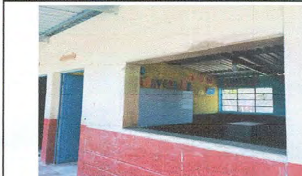
Foto 2: Módulo 1. fabricación e instalación de ventana de metal
