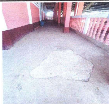
Foto2: MODULO 1. Sustitución de torta de cemento por piso cerámico
