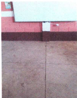
Foto1: MODULO 1. Sustitución de torta de cemento por piso cerámico
