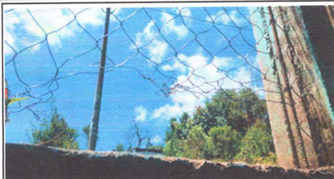
Foto 7. MURO PERIMETRAL: Reparación de tubo Hg y malla galvanizada.
