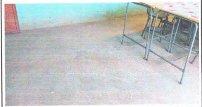
Foto 4: MODULO 1: Sustitucion de torta de cemento por piso cerámico
