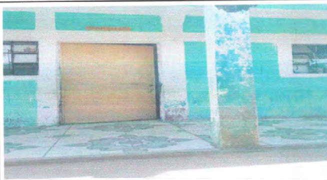
Foto1: PINTURA GENERAL: Pintura en muros interiores y exteriores
