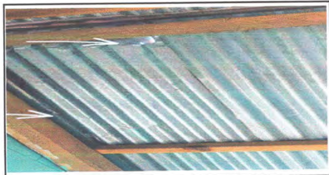
Foto 6: MODULO 1: Sustitucion de estructura de soportes de madera por metal.
