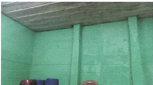
FOTO 1 Modulo 1: Pintura en muros interiores
