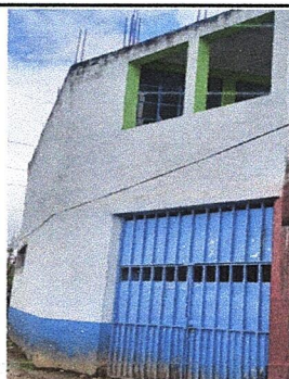
FOTO 4 Modulo 2: Pintura en muros exteriores
