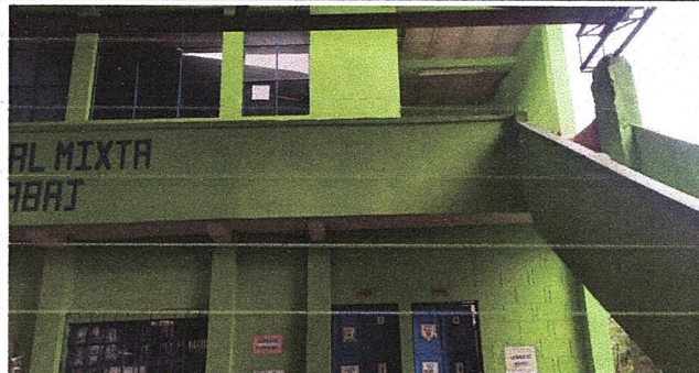
FOTO 2 Modulo 1: Pintura en muros exteriores
