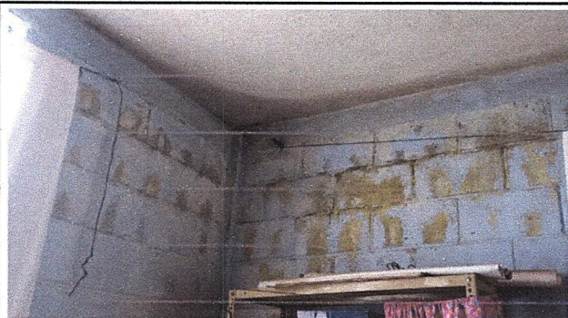
FOTO 3 Modulo 2: Pintura en muros interiores
