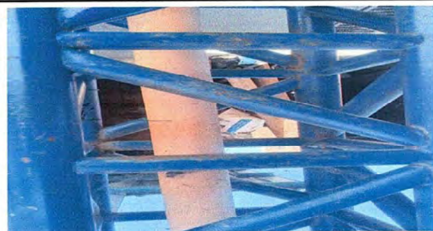
Módulo 3: Reparación de bajada de agua pluvial, tubo "3" FOTO 17
