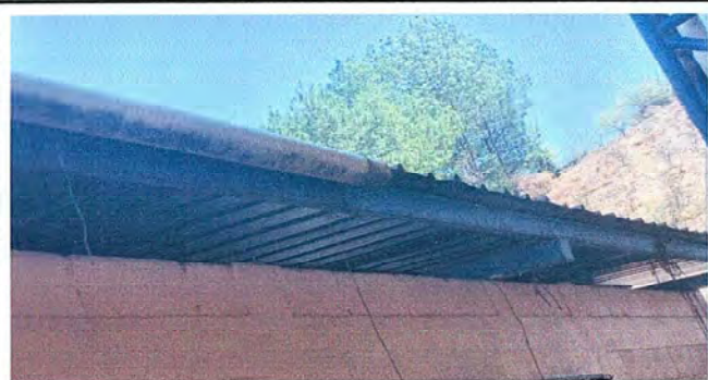
Módulo 4: Sustitución de canal de PVC, Sustitución de soporte o pescante de metal para canal. FOTO 19
