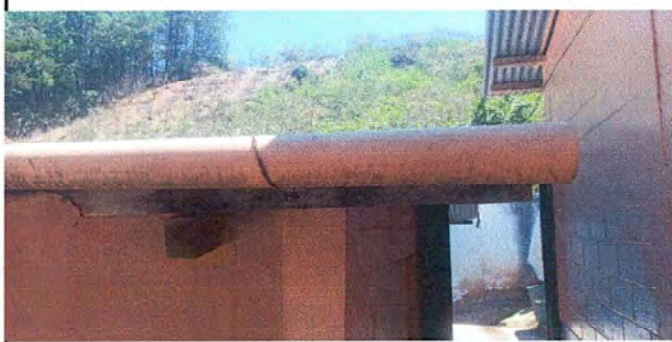
Módulo 2: Sustitución de soporte o pescante de metal para canal. FOTO 13
