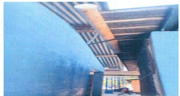
Módulo 3: Sustitución de canal de PVC y Sustitución de soporte o pescante de metal para canal. FOTO 16
