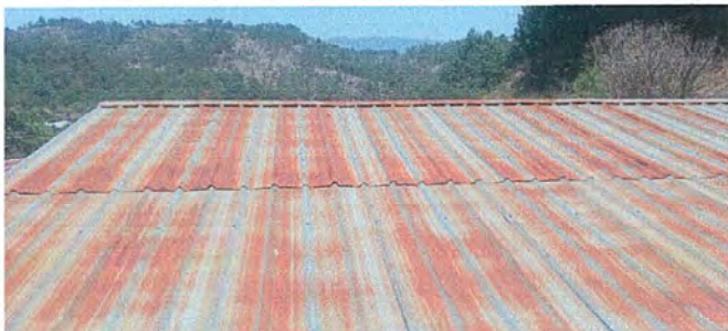
Módulo 3: Sustitución de lámina, por lamina troquelada aluzinc calibre 26, Sustitución de capote de lámina para lámina troquelada y Sustitucion de elementos de fijación (tornillos) FOTO 15
