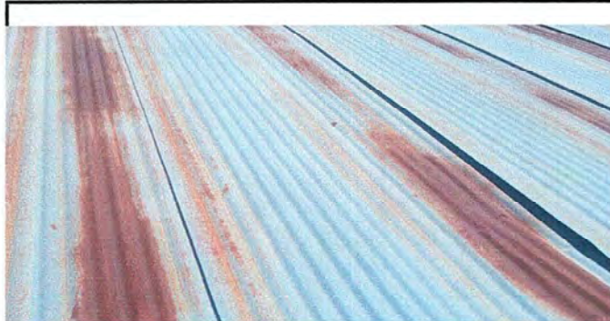
Módulo 2: Sustitución de lámina, por lámina troquelada aluzinc calibre 26. FOTO 8
