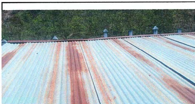
Módulo 2: Sustitución de capote de lámina para lámina troquelada. FOTO 9
