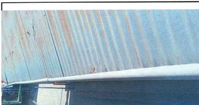
Módulo 1: Sustitución de canal de PVC. FOTO 5
