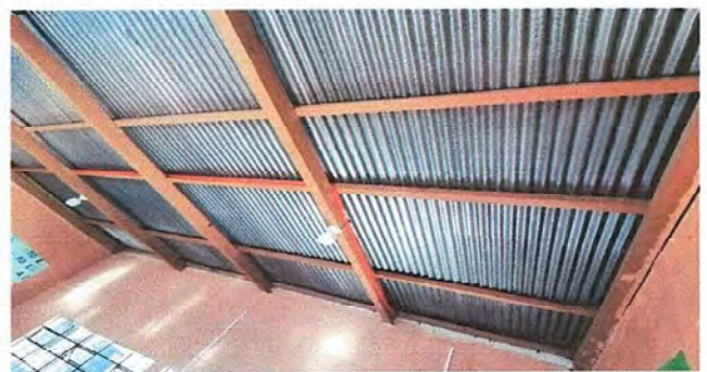
Módulo 1: Sustitución de estructura de soporte de madera, por metal. FOTO 4
