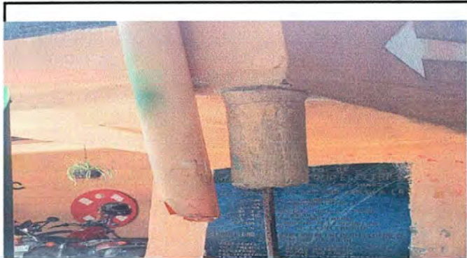
Módulo 1: Reparación de bajada de agua pluvial, tubo "3" FOTO 7
