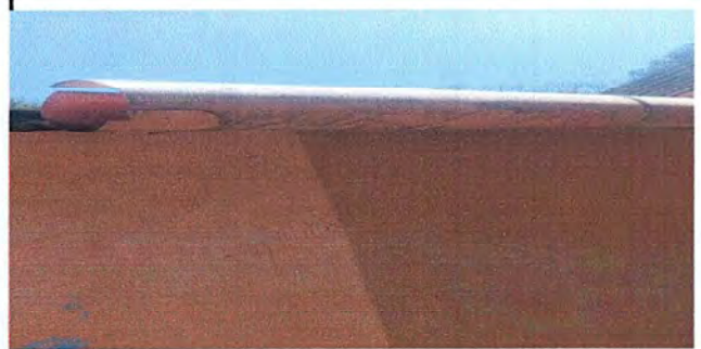
Módulo 2: Reparación de bajada de agua pluvial, tubo "3" FOTO 14
