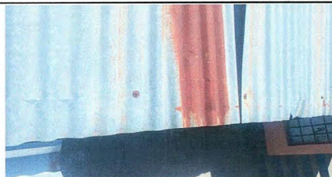
Módulo 2: Sustitución de elementos de fijación (tornillos) FOTO 10
