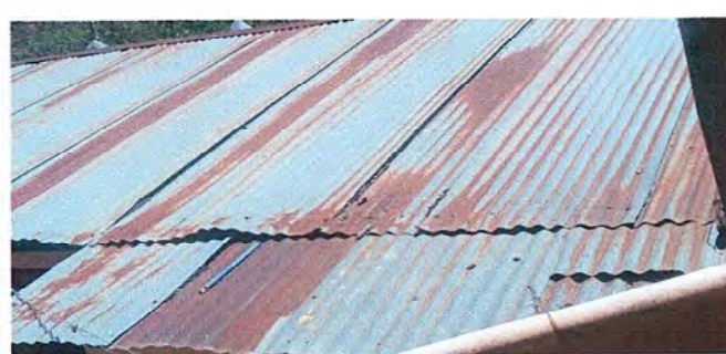
Módulo 2: Sustitución de canal de PVC. FOTO 12
