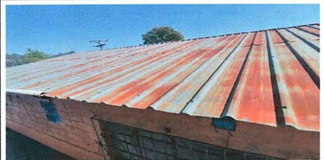
Módulo 4: Sustitución de lámina, por lámina troquelada aluzinc calibre 26, Sustitución de capote de lámina para lámina troquelada y Sustitucion de elementos de fijación (tornillos) FOTO 18
