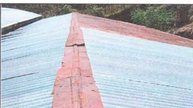
Foto 4: MODULO 1 sustitucion de capote de lamina a capote de lamina troquelada
