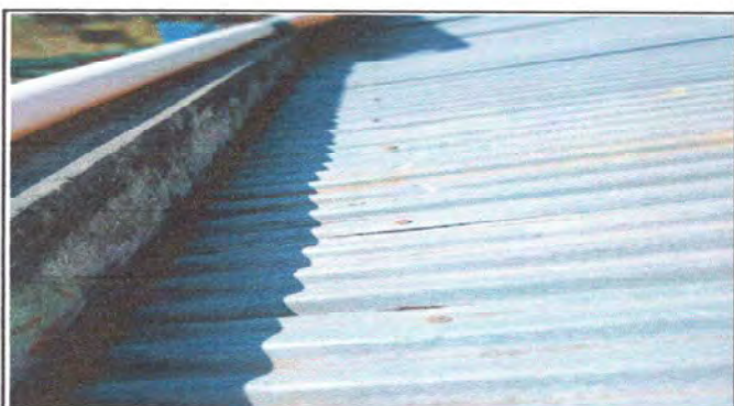
Foto 3: MODULO 1 sustitucion de elementos de fijación
