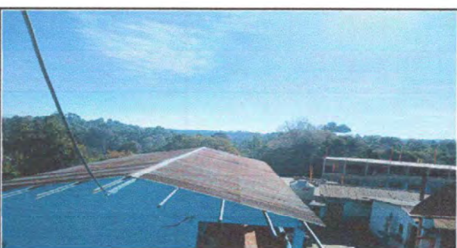
Foto 6: MODULO 2 sustitucion de lamina por lamina troquelada aluzinc. Cal.26
