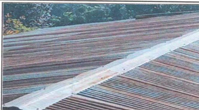
Foto 8: MODULO 2 sustitucion de capote de lamina a capote de lamina troquelada
