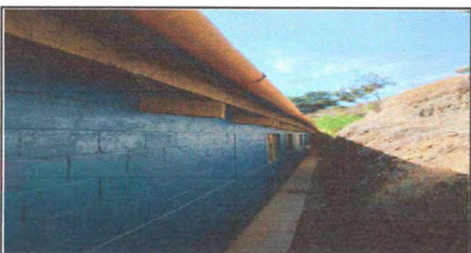
Foto 5: MODULO 1 Sustitución de canal de metal
