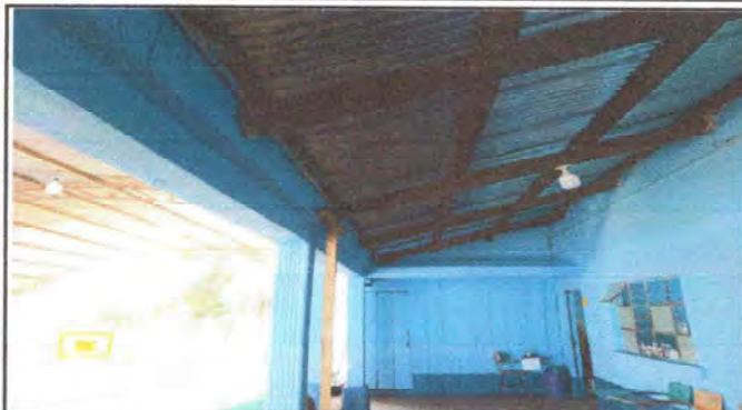
Foto1: MODULO 1 instalación de estructura de soporte
