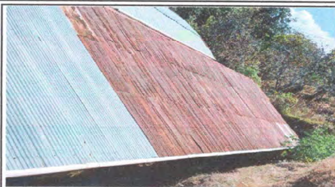
Foto 2: MODULO 1 sustitucion de lamina por lamina troquelada aluzinc. Cal.26
