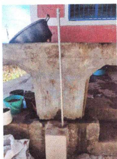
Foto 3: MODULO 1 Sustitución de pila de cemento de dos lavaderos
