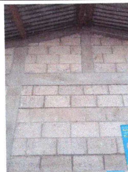
Foto 2: MODULO 1. Aplicación de repello de muro de contención
