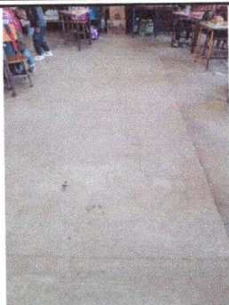
Foto 1: MODULO 1. Sustitución de torta de cemento por piso cerámico
