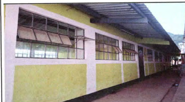
Foto 3: Pintura de muro interior y exterior, sustitución de vidrio y colocación de balcones.
