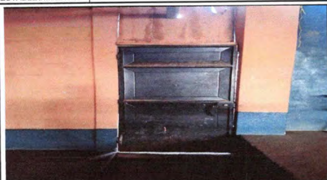
Foto 1: Módulo 1. Pintura de muro interior y exterior, sustitución de puerta, sustitución de vidrio.
