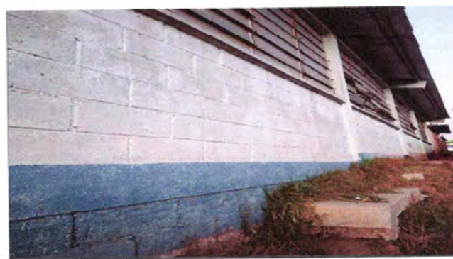
Foto 4: Módulo 4. Pintura de muros interior y exterior, sustitución de vidrios, colocación de puerta.
