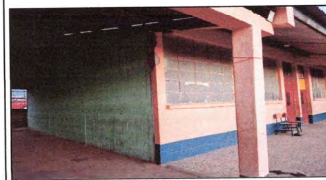
Foto 5: Módulo 5. pintura de muro interior y exterior.
