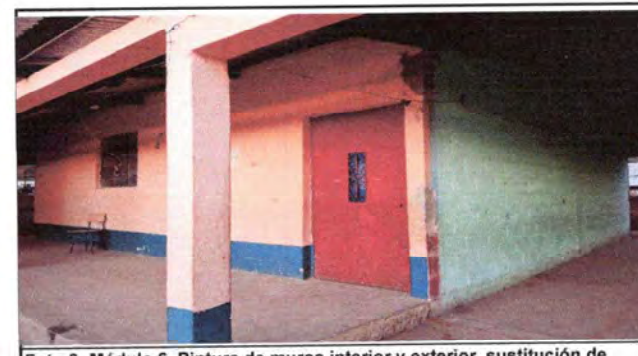
Foto 6: Módulo 6. Pintura de muros interior y exterior, sustitución de vidrio.
