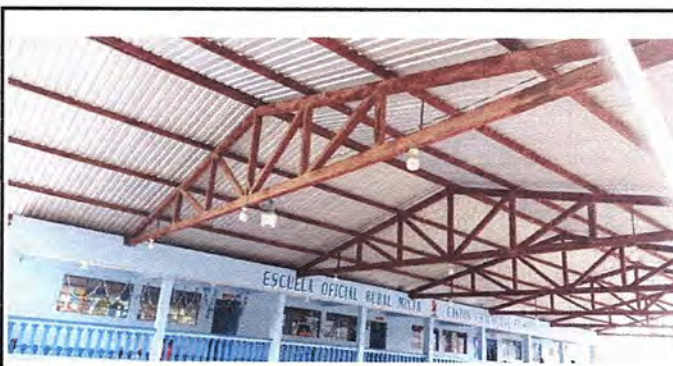
Foto 6: MODULO 5. PATIO MATERIAL DE ESTRUCTURA SOPORTE DE METAL
