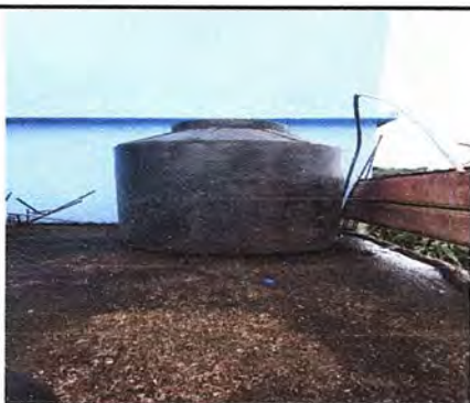
Foto 5: MODULO 6. SUSTITUCIÓN DE DEPOSITO DE AGUA
