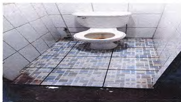
Foto 4: MODULO 6. SUSTITUCIÓN DE INODOROS Y PISO ANTIDESLIZABLE
