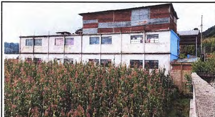
Foto 3: MODULO 5. PINTURAS DE MUROS DE EXTERIORES DE AULAS
