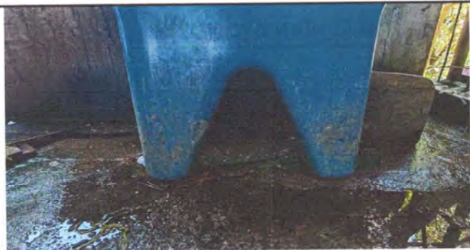
FOTO 5 Modulo 3: Sustrución de reposadera.
