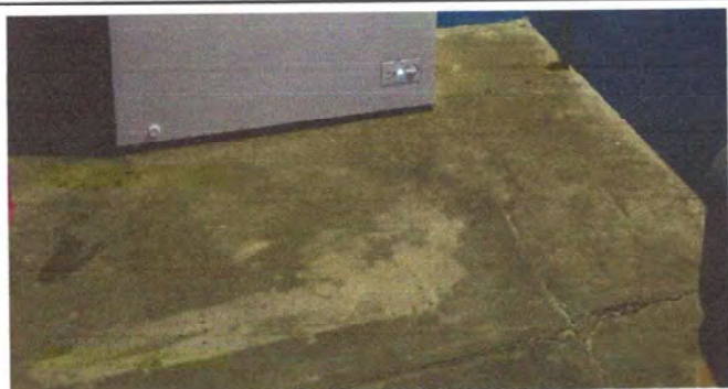
FOTO 3 Modulo 1: Sustrución de piso de torta de concreto por piso cerámico
