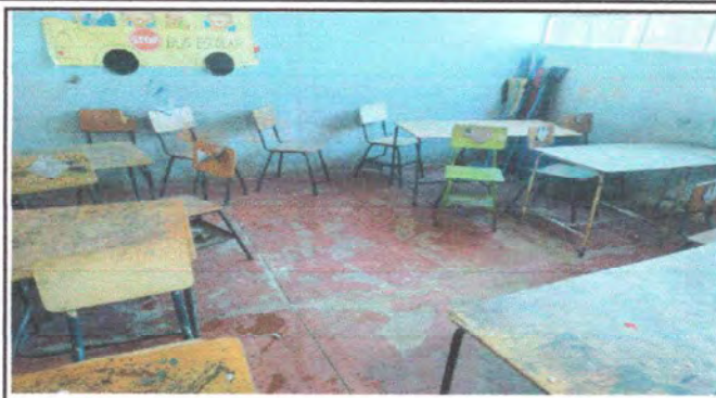
Foto 2: MÓDULO 2. Sustrucción de torta de cemento por piso cerámico
