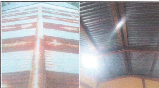
Foto 1: MÓDULO 1. Sustrucción de lámina, por lámina troquelada aluzinc calibre 26 y Sustrucción de estructura de soporte de madera por metal.
