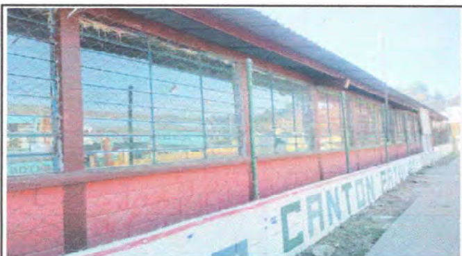
Foto 3: MURO PERIMETRAL. Reparación con tubo hg y malla galvanizada
