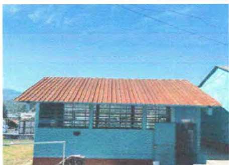
Foto 7: Módulo 2 Sustitución de lamina por lamina troquelada aluzinc calibre 26/sustitucion de capote de lámina para lámina troquelada/Sustitucion de elementos de fijacion (tornillos)
