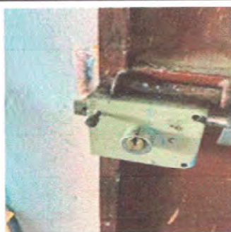
Foto 5: Módulo 1 Sustrucción de chapa
