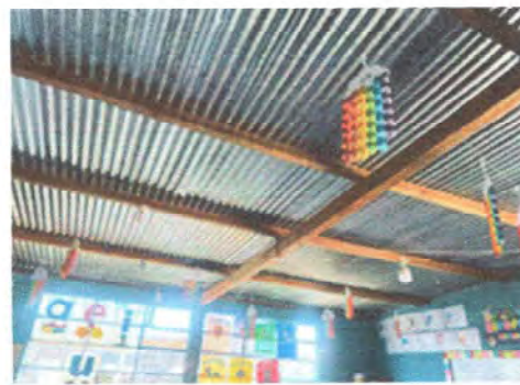
Foto 2: Módulo 1 Sustrucción de estructura de soporte de madera por metal
