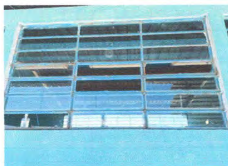
Foto 10: Módulo 2 Sustitucion de vidrios/Suministro e instalación de balcon de hierro en ventana
