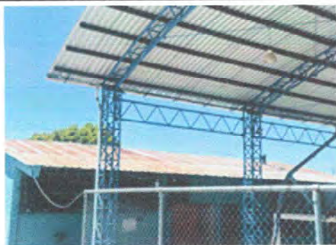
Foto 1: Módulo 1 Sustrucción de lámina por lámina troquelada aluzinc calibre 26/ Sustrucción de capote de lámina para lámina troquelada/ Sustrucción de elementos de fijación (tornillos)
