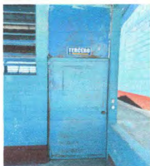
Foto 9 : Módulo 2 Mantenimiento a puerta de metal
