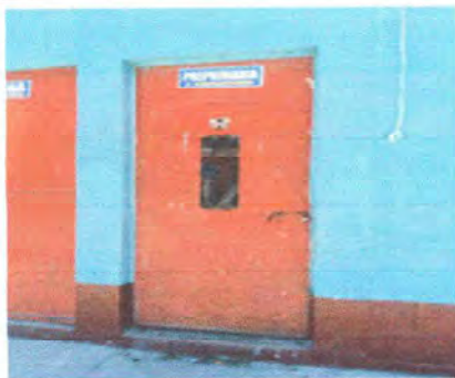
Foto 3: Módulo 1 Mantenimiento de puertas de metal
