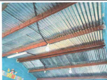
Foto 12: Módulo 3 Mantenimiento a estructura de soporte de metal
