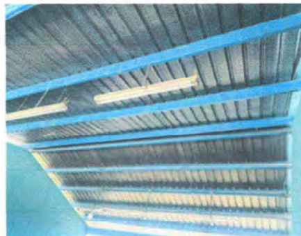
Foto 8: Módulo 2 Mantenimiento a estructura de soporte de metal
