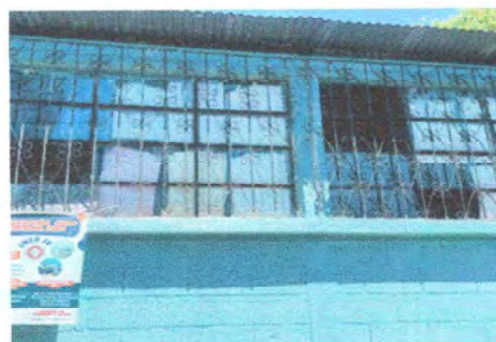
Foto 4: Módulo 1 Sustrucción de vidrios
