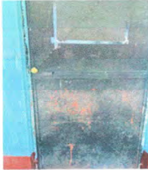
Foto 13: Módulo 3 Mantenimiento a puertas de metal
