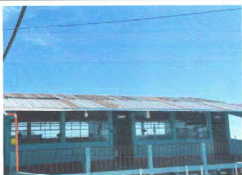
Foto 11: Módulo 3 Sustitución de lámina por lámina troquelada aluzinc calibre 26/Sustitucion de capotes de lamina para lamina troquelada/ Sustitución de elementos de fijación (tornillos)
