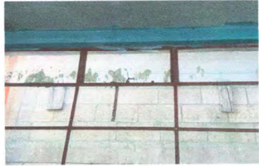
Foto 14: Módulo 3 Sustitución de vidrios
