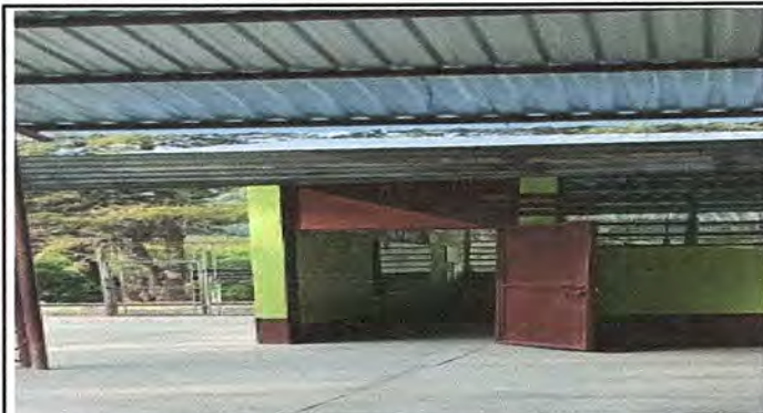
Foto 7: MODULO 2 MANTENIMIENTO A ESTRUCTURA DE PUERTA DE METAL
