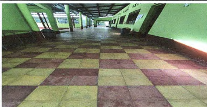
Foto1: MODULO 1 SUSTITUCIÓN DE PISO DE GRANITO POR PISO CERAMICO
