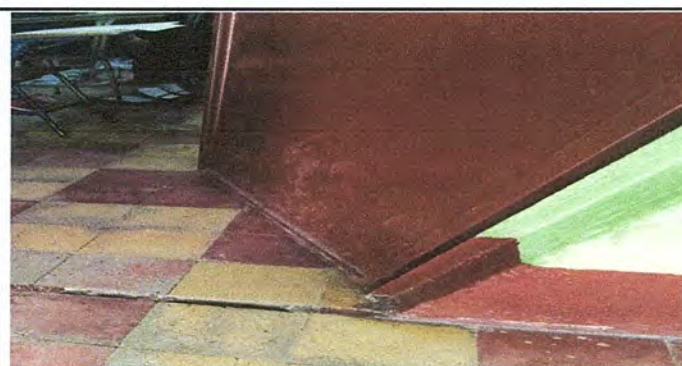
Foto 4: MODULO 1 MANTENIMIENTO A ESTRUCTURA DE PUERTA DE METAL
