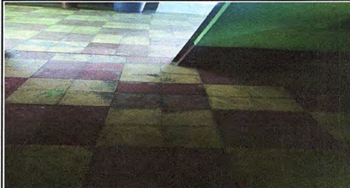
Foto 2: MODULO 1 SUSTITUCIÓN DE PISO DE GRANITO POR PISO CERAMICO
