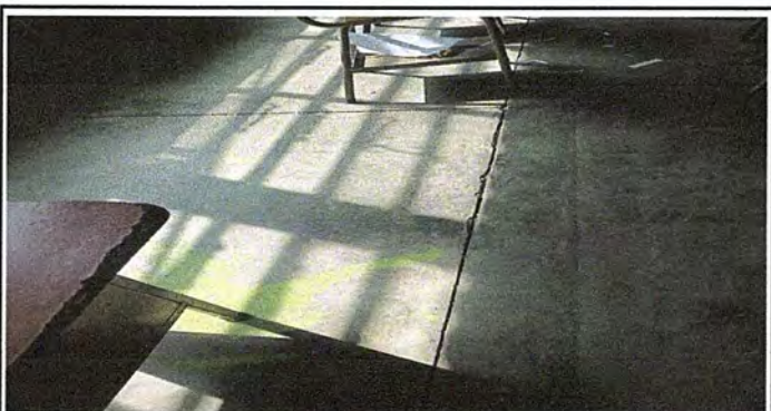
Foto 5: MODULO 2 SUSTITUCIÓN DE PISO DE CEMENTO LIQUIDO POR PISO CERAMICO
