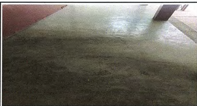
Foto 6: MODULO 2 SUSTITUCIÓN DE PISO DE CEMENTO LIQUIDO POR PISO CERAMICO
