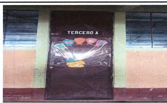
Foto 6. Modulo 3. Mantenimiento de estructura de puerta, lijado. Cambio de tubo, cepillado, sujeciones, aplicaci3n de pintura.
