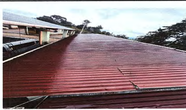
Foto 2. Modulo 1. Sustrucción de lamina troquelada aluzinc calibre 26
