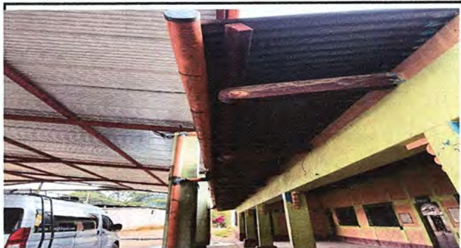
Foto 3. Modulo 1 Sustrucción de canal de PVC por canal de metal
