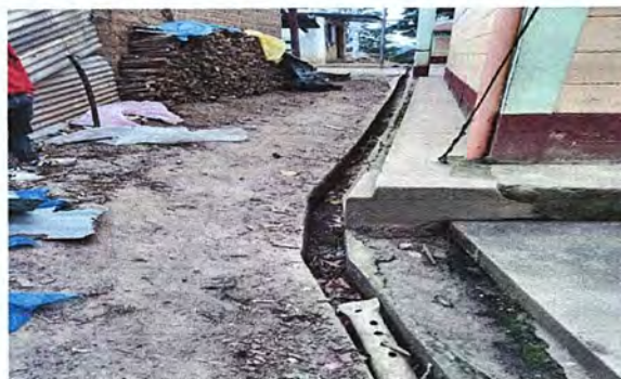
Foto 8. Area Exterior. Reparación de cuneta de concreto.
