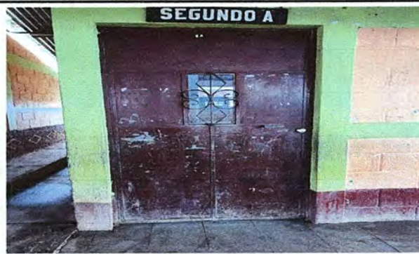
Foto 4. Modulo 1. Mantenimiento de estructura de puerta, lijado. Cambio de tubo, cepillado, sujeciones, aplicaci3n de pintura.
