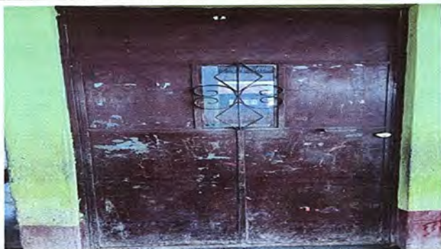
Foto 7. Modulo 4. Mantenimiento de estructura de puerta, lijado. Cambio de tubo, cepillado, sujeciones, aplicación de pintura.
