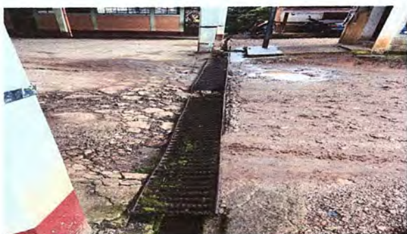
Foto 9. Area Exterior. Sustitucion de regilla para cuneta de concreto
