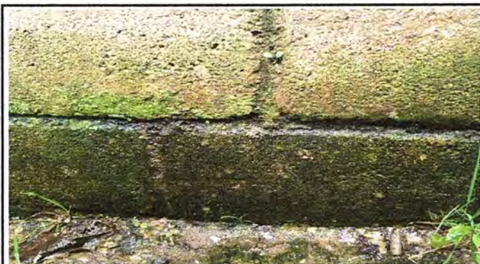
Foto 3: Módulo 1; repello de muro.
