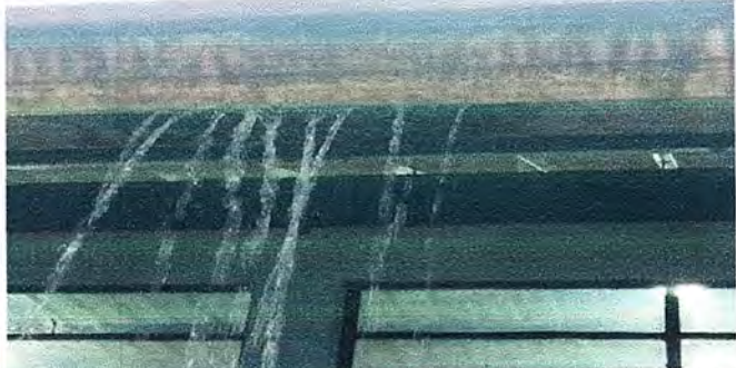
Foto7: Módulo 2; Mantenimiento de estructura pluvial.
