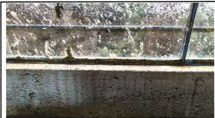
Foto 4: Módulo 1; sustitución de ventanas de metal por ventanas de PVC, incluye vidrio.
