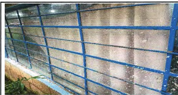
Foto 6: Módulo 1; suministro e instalación de balcón de metal.
