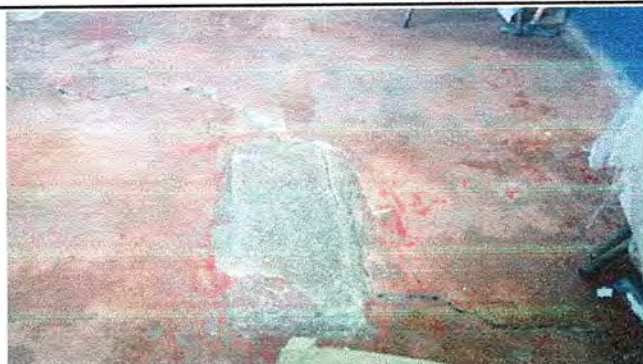
Foto 10: Módulo 3; sustitución de piso de torta de concreto por piso de granito.
