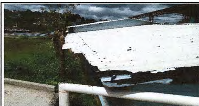
Foto 5: Módulo 1; suministro e instalación de canal de pvc.
