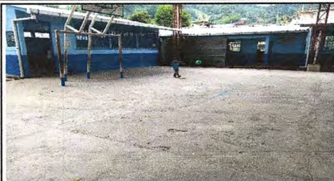
Foto 1: Cancha deportiva; sustitución de planchas de concreto.
