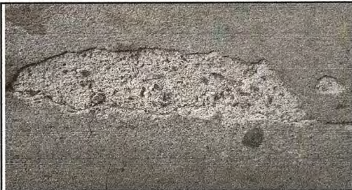
Foto 2: Cancha deportiva; sustitución de planchas de concreto.
