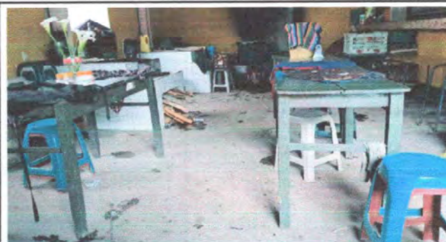
Foto 10: Modulo 4. Sustrución de torta de coconreto por piso cerámico (cocina)
