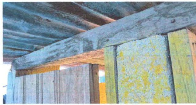
Foto 2: MODULO 1. Sustitucion de estructura de soporte de madera por metal
