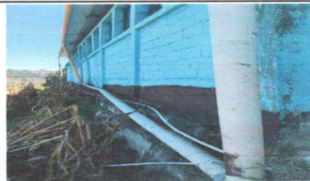
foto 4: Modulo 1: reparacion de bajada de agua pluvial
