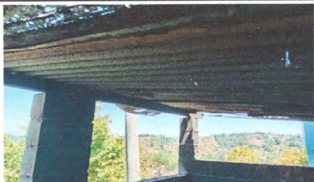
Foto 7: MODULO 3. Sustrución de estructura de soporte de madera por metal
