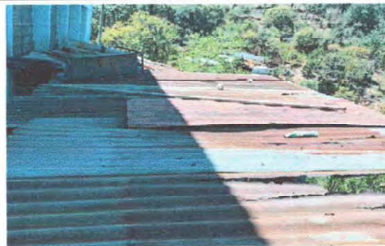
Foto 8: MODULO 3. Sustrución de láminas por láminas troquelada aluzinc calibre 26
