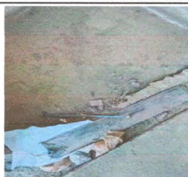
Foto 8: MODULO 1. sustitución de torta de concreto por piso cerámico
