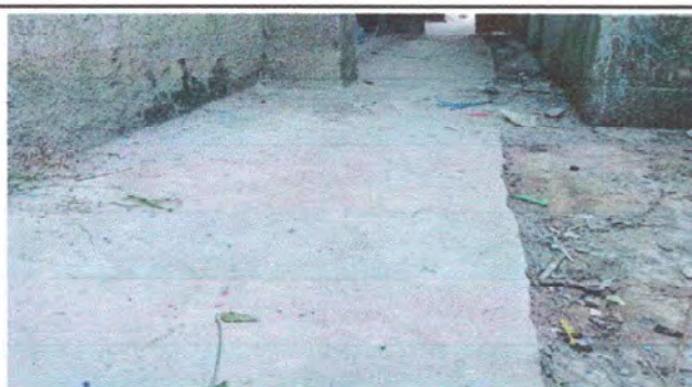
Foto 1: MODULO 1. Sustitución de torta de concreto por piso cerámico
