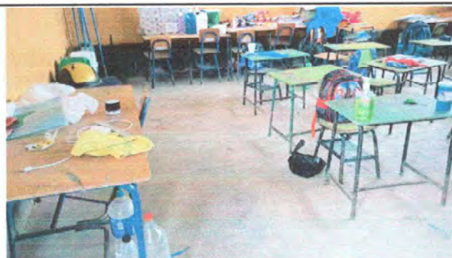
Foto 9: MODULO 3. Sustrución de concreto por piso cerámico
