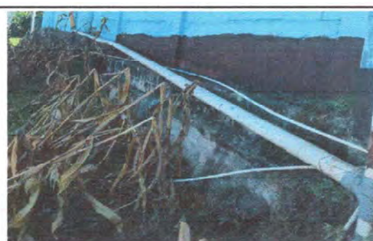
Foto 11: MODULO 1, Instalación de tubería PVC para aguas negras
