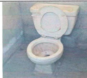
Foto 6: MODULO 1. Sustitución de inodoro
