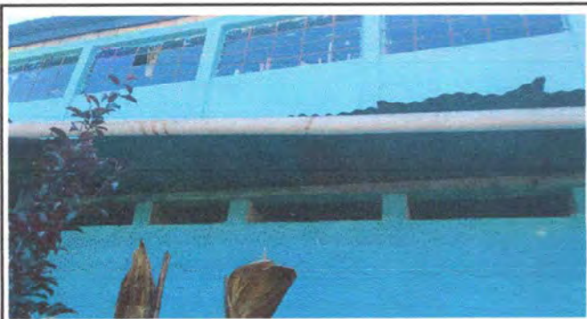
Foto 3: MODULO 1 sustitución de canal
