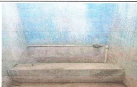
Foto 7: MODULO 1. sustitución de mingitorio
