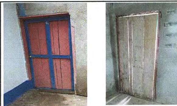
Foto 8: Modulo 2. Sustitución de puerta de madera por metal.
