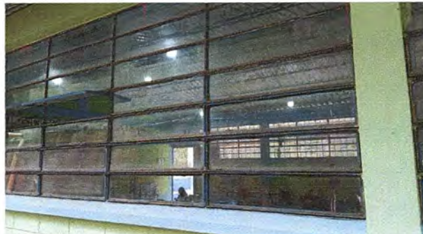
Foto 2: Módulo 1: Suministro e instalación de balcones de metal
