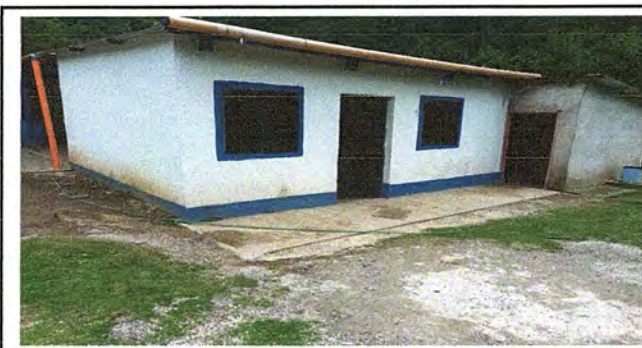
Foto 12: Modulo 3: Pintura en muro exteriores e interiores
