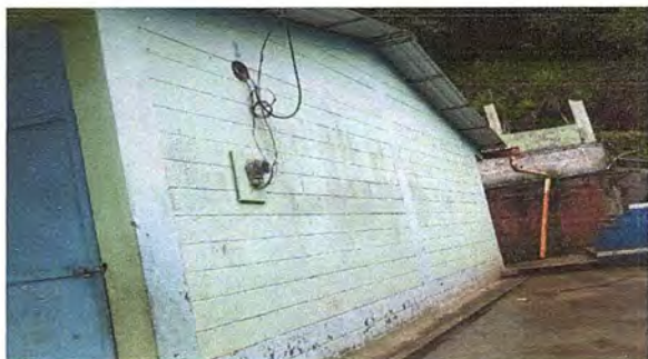
Foto 3: Módulo 1: Pintura en muro exteriores e interiores
