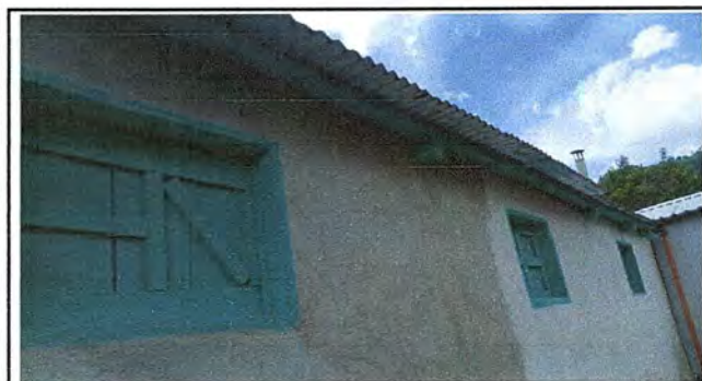
Foto 9: Modulo 2: Sustitución de ventana de madera por metal más vidrio.
