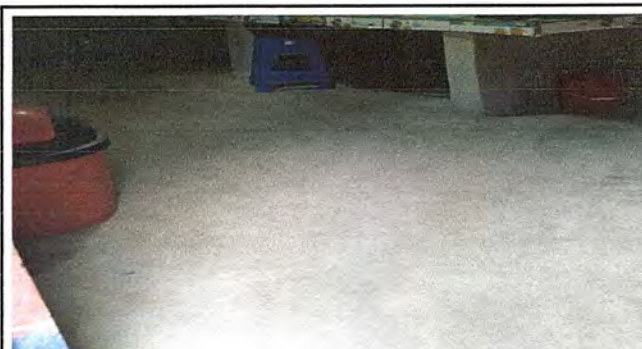
Foto 10: Modulo 2. Sustitución de piso de torta de concreto por piso cerámico.
