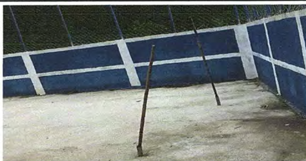
Foto 4: Cancha. Sustitución de tubos de portería
