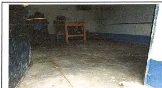
Foto 11: Modulo 3: Sustitución de piso de torta de concreto por piso cerámico
