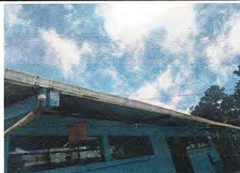
Foto 2: MODULO 1. Sustitución de canal de PVC.
