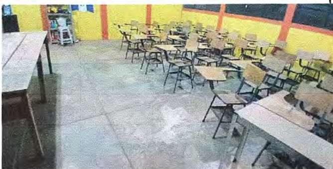
Foto 3: MODULO 1. Sustitución de pintura en interior.
