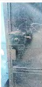
Foto 5: MODULO 1. Sustitución de Chapa modulo 1.
