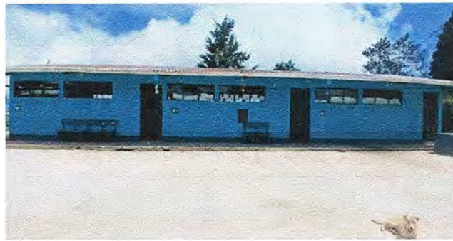
Foto 4: MODULO 1. Suministro he instalación de balcones de hierro en ventanas
