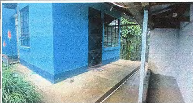
Foto 7: MODULO 2. Suministro e instalación de balcones.
