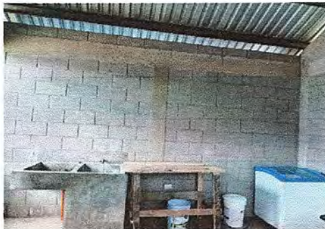
Foto 8: MODULO 2. Pintura en muro interior.
