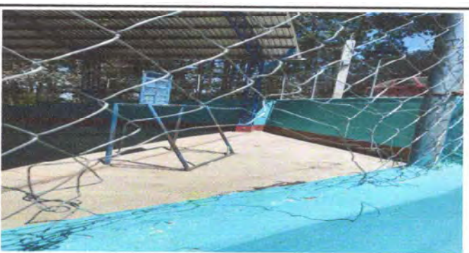
Foto 17: Reparación de tubo hg malla galvanizada.
