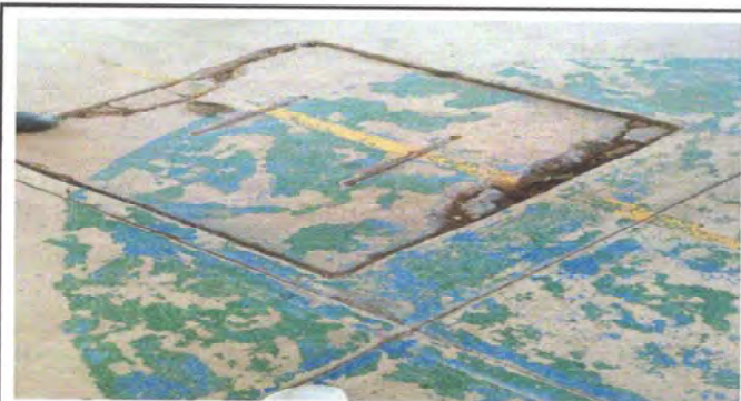
Foto 15: CANCHA. Reparación de planchas de concreto de patio.
