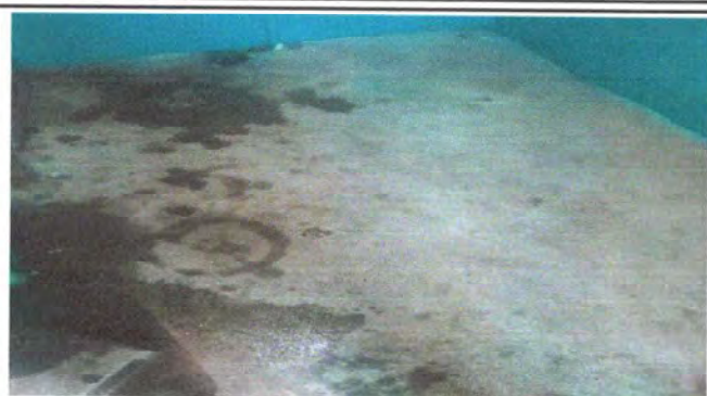
Foto 7: Módulo 1. Sustrucción de torta de cemento por piso cermamico.
