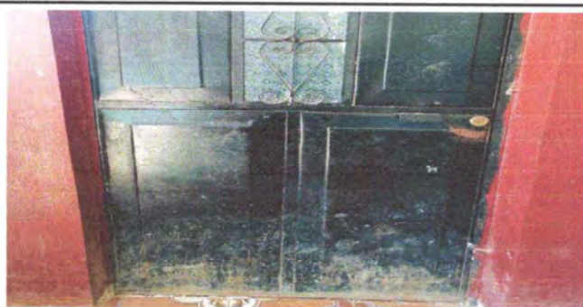
Foto 11: MODULO 2. Sustrucción de puertas.
