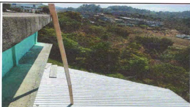
Foto 3: Módulo 1 Reparación de bajada de agua pluvial PVC 3.
