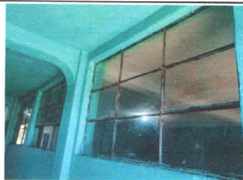
Foto 2: Módulo 1 Fabricación e instalación de balcones de hierro.
