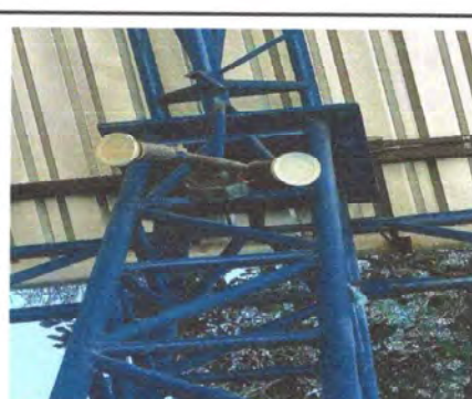
Foto 16: CANCHA. Sustitución de lamparas tipo led.
