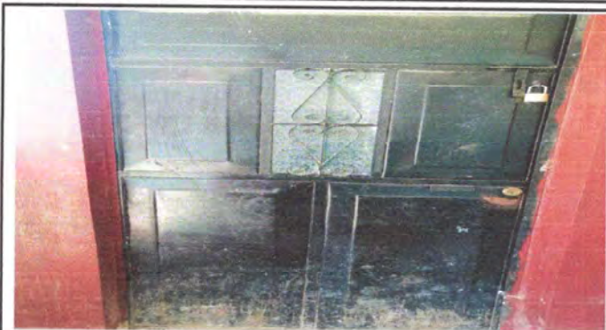
Foto 1: Módulo 1 Sustitución de puertas.
