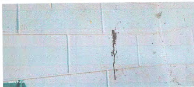
Foto 4: Modulo 2. Pintura en muros interiores y exteriores.
