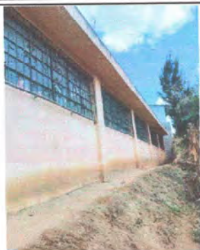
Foto 1: Modulo 2. Pintura en muros interiores y exteriores.
