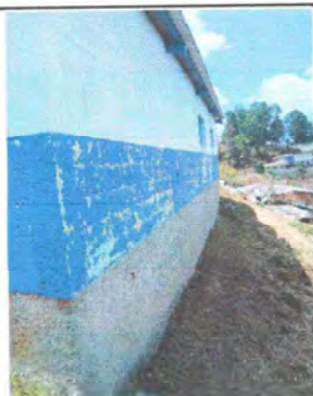
Foto 3: Modulo 2. Pintura en muros interiores y exteriores.
