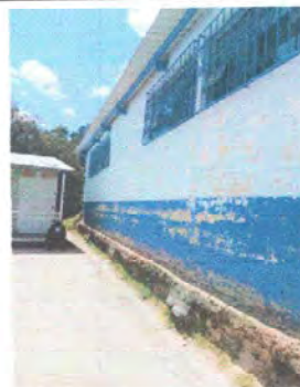
Foto 2: Modulo 2. Pintura en muros interiores y exteriores.
