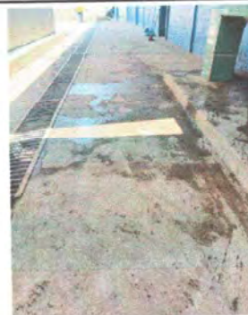
Foto 2: Modulo 1. Sustitucion de piso de torta de concreto por piso ceramico.
