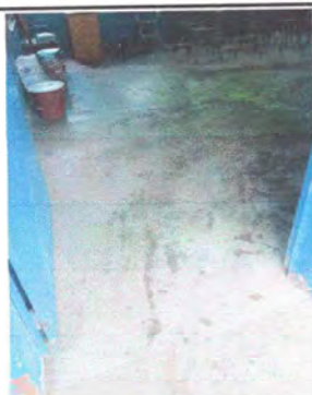
Foto 3: Modulo 1. Sustitucion de piso de torta de concreto por piso ceramico.
