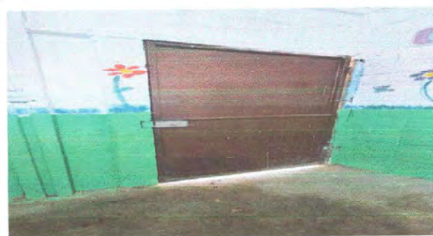
Foto 4: Modulo 4 Mantenimiento a estructura puerta de metal (lijado, cepillado, sujeciones, aplicación de pintura)
